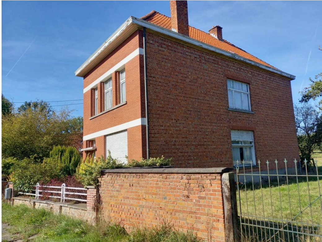
Figuur 6 Zicht op de woonst binnen het plangebied (bron: opdrachtgever)
