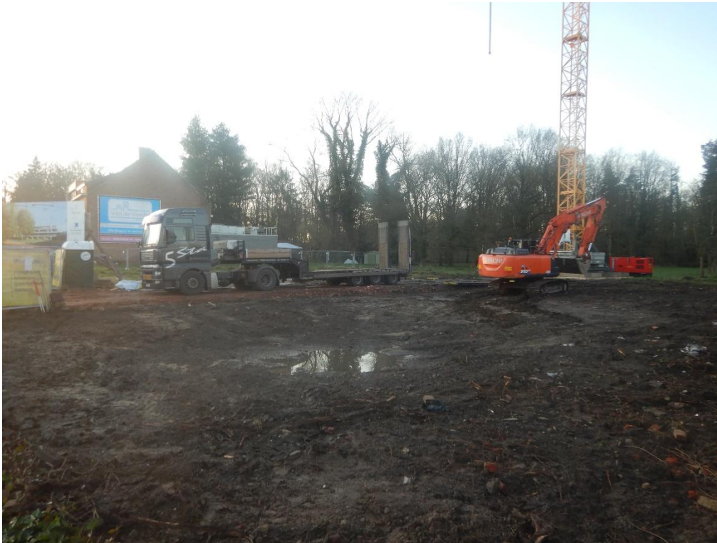
Figuur 23 Zicht op de werfweg, centraal in het projectgebied
