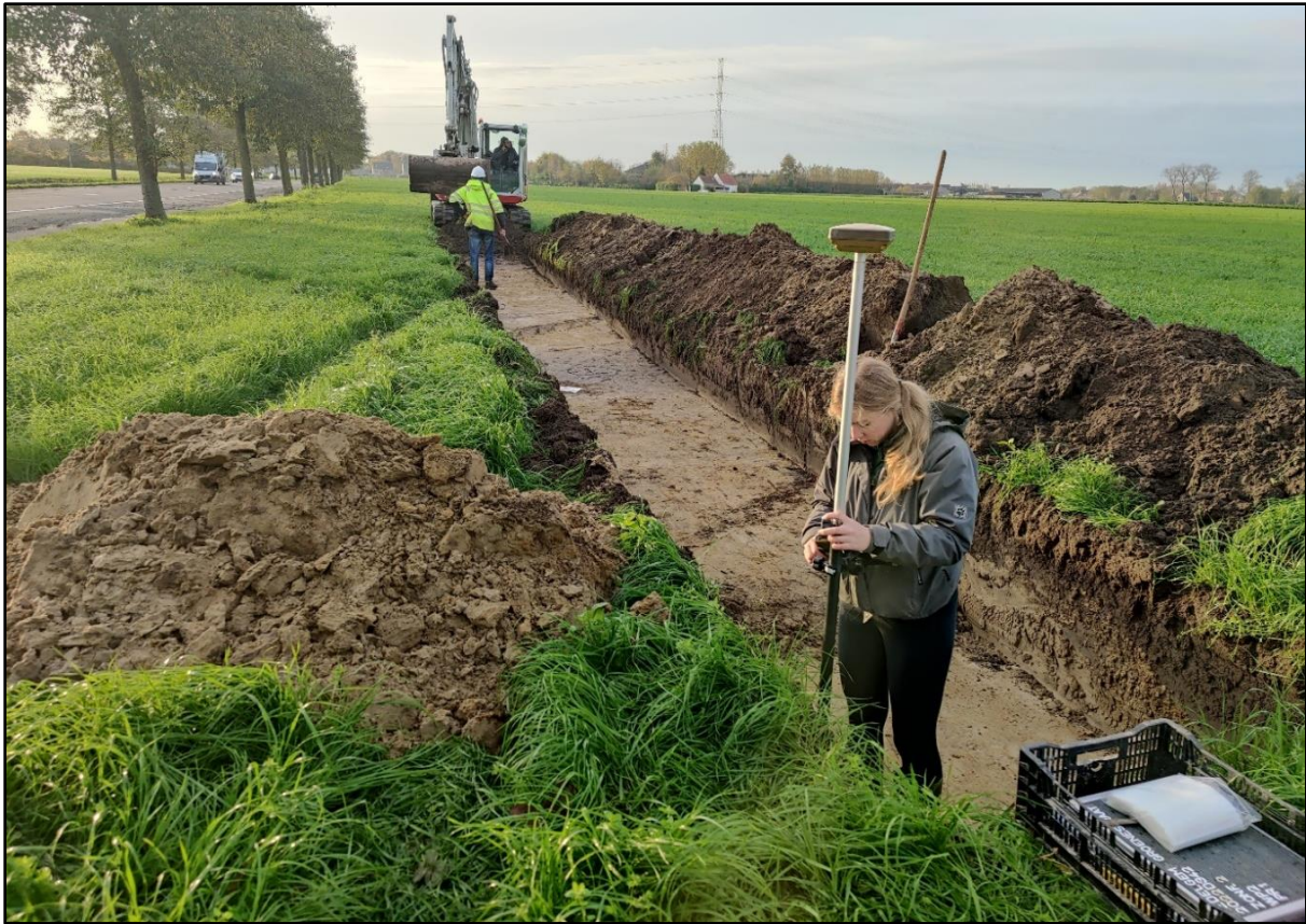
Figuur 33: Aanleggen en registreren langs de Groenestraat; zone 2 (ABO nv 2022)
