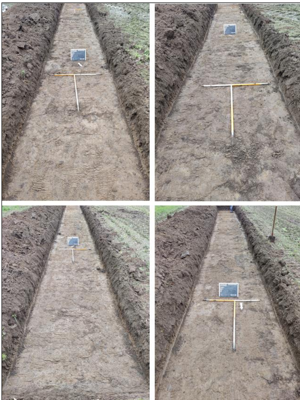
Figuur 40: Overzichtsfoto's van werkput 1.2 (boven) en 1.3 (onder)
