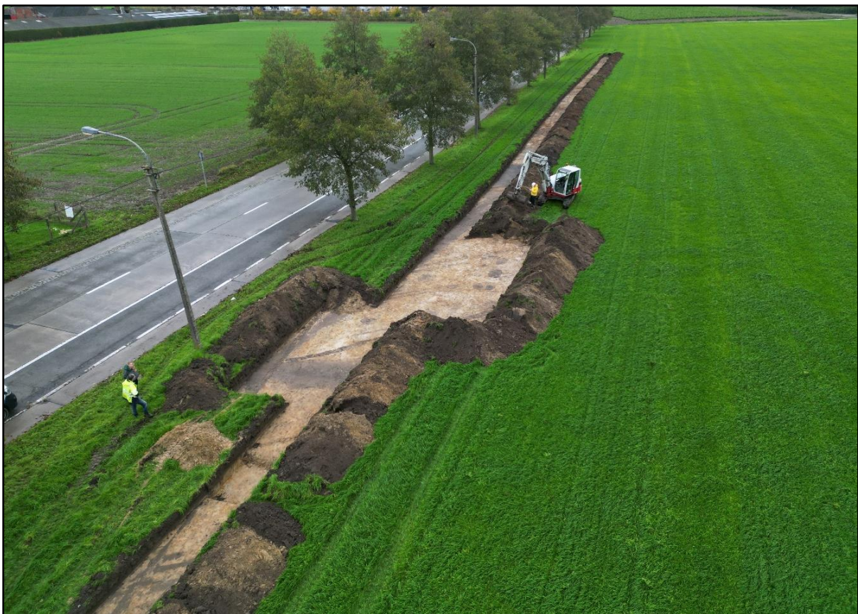
Figuur 34: Drone-opname tijdens het aanleggen langs de Groenestraat; zone 2 (ABO nv 2022)
