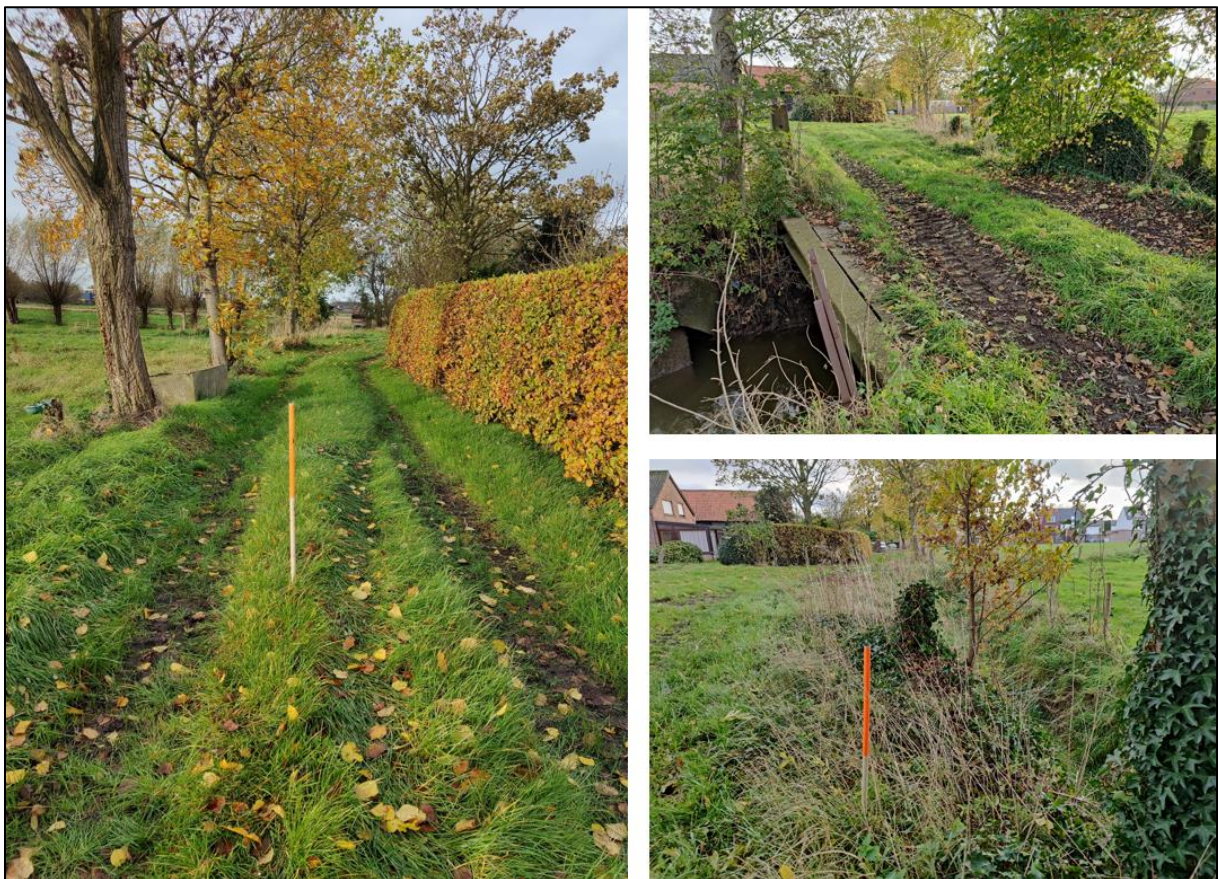
Figuur 49: De locatie van de landweg, Moubeek en duiker over Moubeek waar het aanleggen van een proefsleuf praktisch niet uitvoerbaar was
