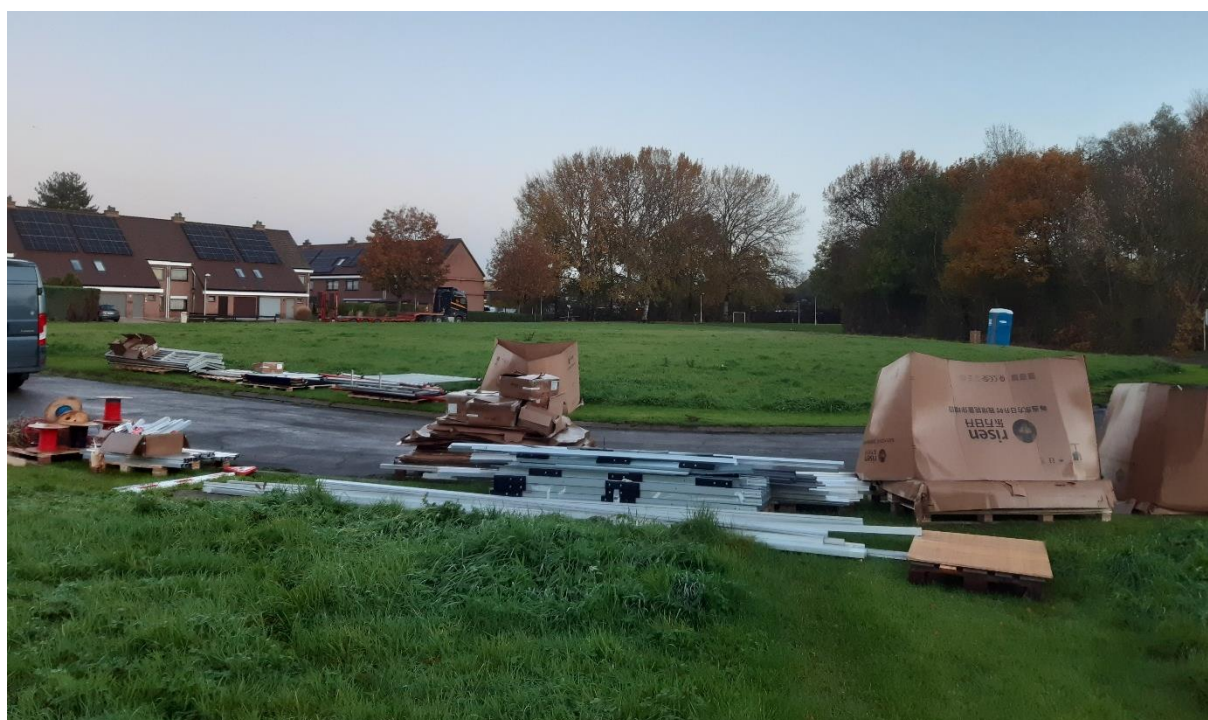
Figuur 12: Zicht op het centrale deel van het plangebied, met de aftakking van de Camille Huysmansstraat en de gestapelde bouwmaterialen ernaast.
