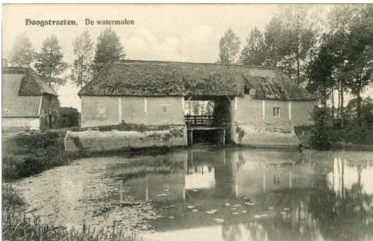
Figuur 24. Oude afbeelding van het molengebouw (oostgevel) (ca. 1900). ( www.laermolen.be )
