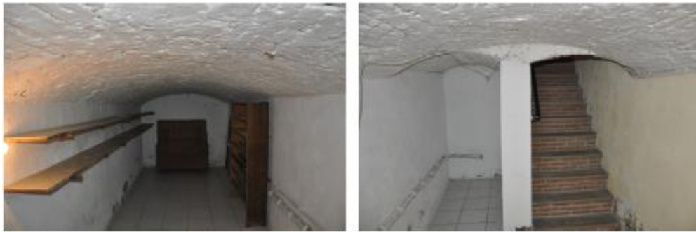
Afbeelding 21: Kelder met steekboogvormig baksteengewelf en keldertrap
