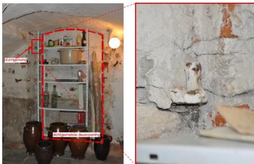
Afbeelding 20: Dichtgemetselde deur en detail duimgehang
