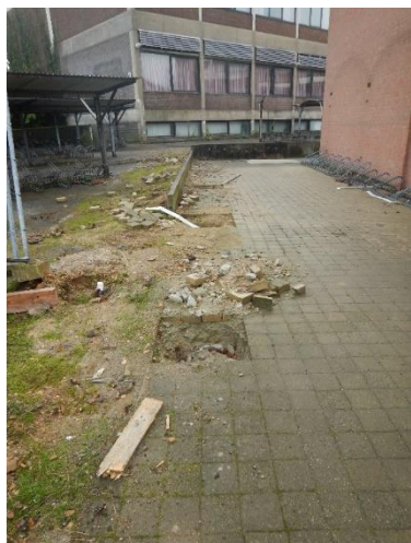
Afbeelding 24: een reeks uitgebroken klinkers met op de achtergrond de betonnen scheidingswand waarvan eerder als sprake (afbeeldingen 9-11).
