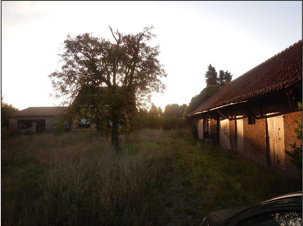
Figuur 1 Zicht op de gebouwen in het noordelijk deel van het plangebied.
