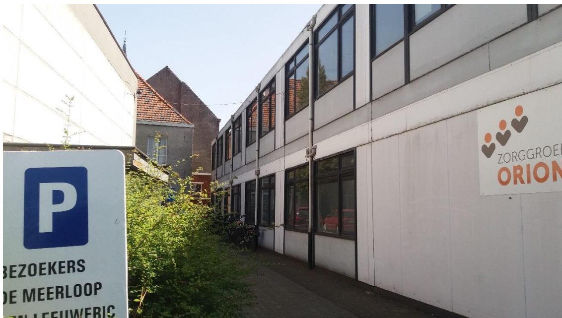
Figuur 3: Foto bestaande toestand
