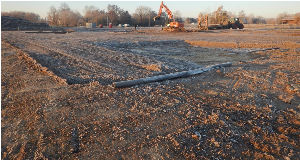
Figuur 6: Overzicht terrein vanuit NO
