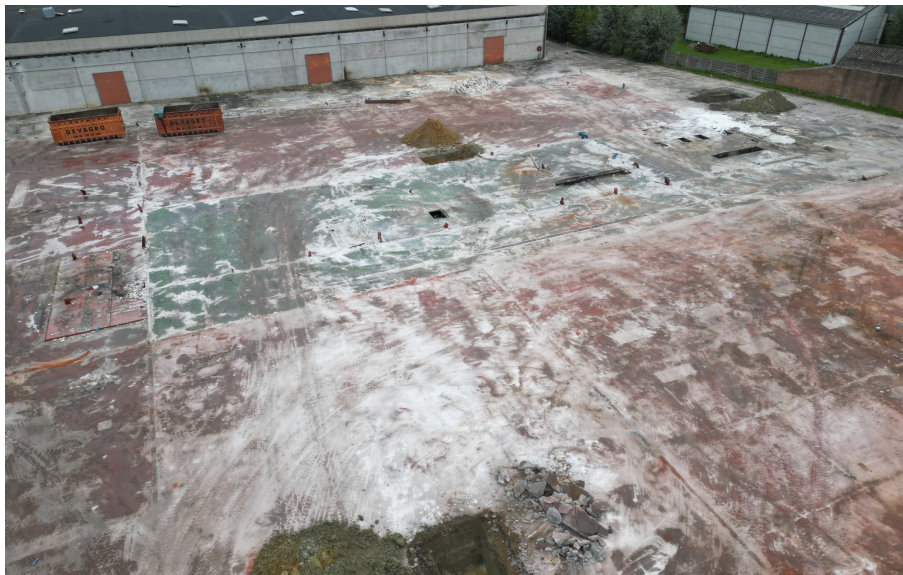
Figuur 1. Luchtfoto van de site voor de afbraak (bron: initiatiefnemer). Onder: dronefoto van de site tijdens de afbraak (foto B. De Smaele, 2022).
