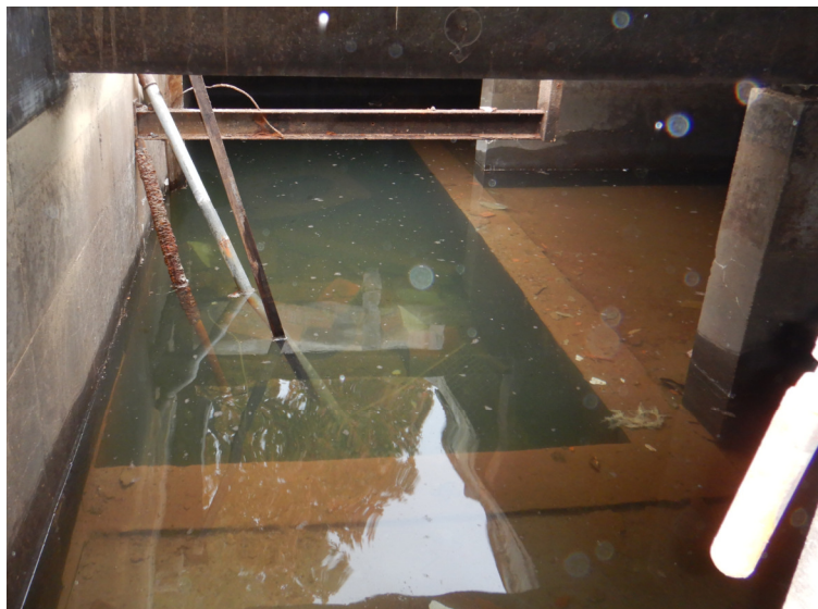
Figuur 3. Boven: zicht op enkele ondergrondse structuren tijdens het plaatsbezoek. Onder: zicht op de sprinklertank (© Hembyse BV).
