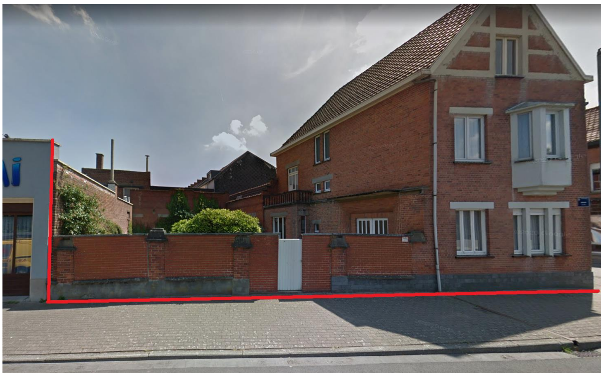
Figuur 7: Huidige situatie van het projectgebied vanuit de Zakkaai (Google Street View 2023)
