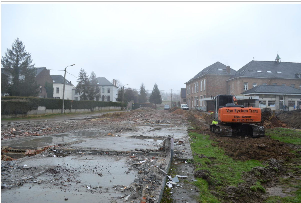
Fig. 2.3: Zicht op het oostelijk deel van het projectgebied vanuit het noorden, met verhardingen en opgepulde ondergrondse structuren.
