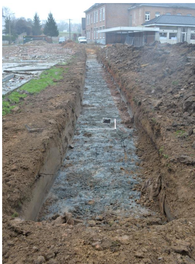
Fig. 2.11: Zicht op proefsleuf 3 richting het zuiden.
