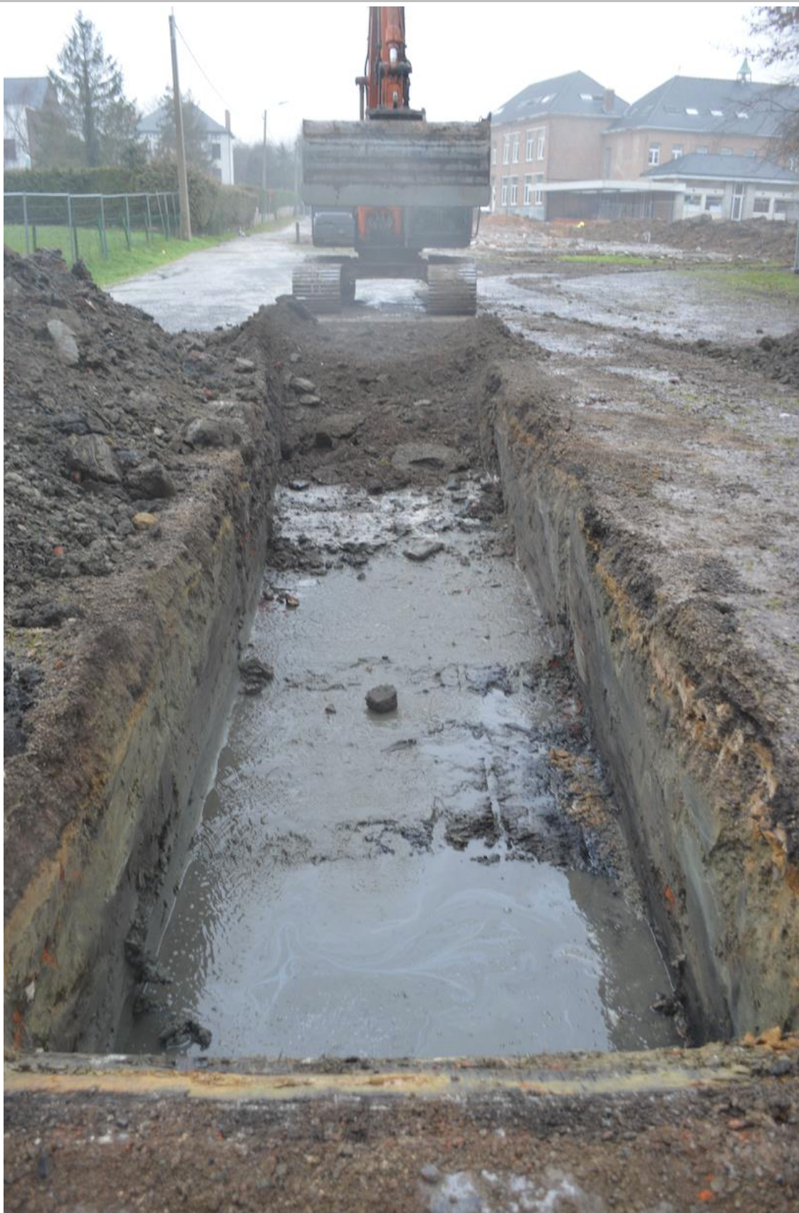
Fig. 2.12: Water stroomt snel uit de sleufwand in de noordelijke sector van proefsleuf 4.
