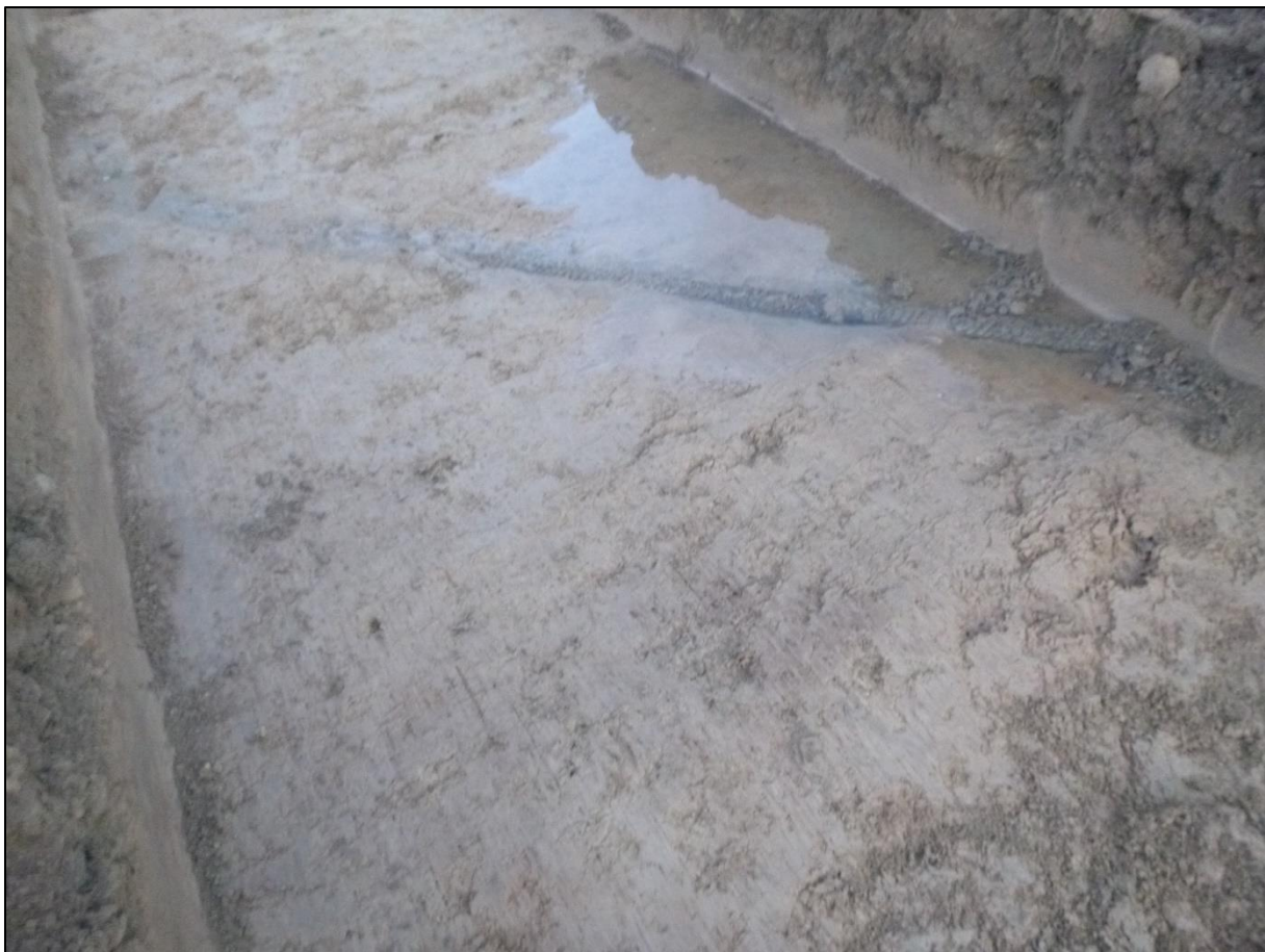
Figuur 51: Zicht op de drainageleiding in het vlak van werkput 1. (ABO nv 2023)
