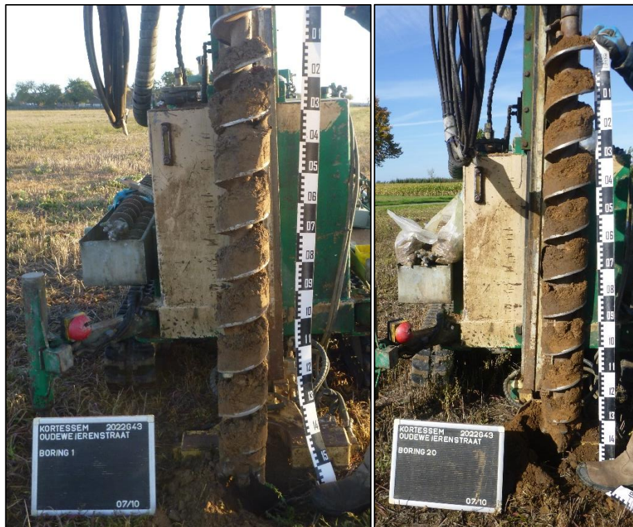
Figuur 18: Foto van boring 1 (links) en boring 20 (rechts). (ABO nv 2022)
