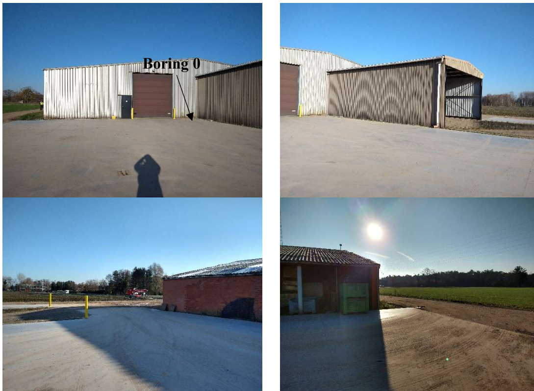
Figuur 6c. Zicht op boring 0. ©LARES
