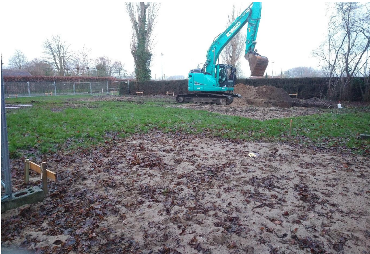
Figuur 7: Situatie op het terrein in de noordwestelijke zone.
