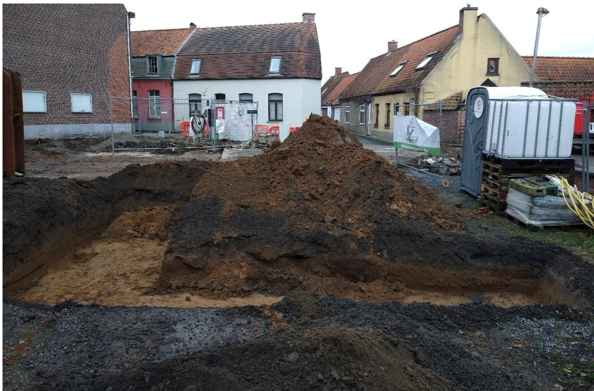
Figuur 8: Situatie na het aanleggen van proefsleuf 4 in de zuidoostelijke hoek van het terrein.
