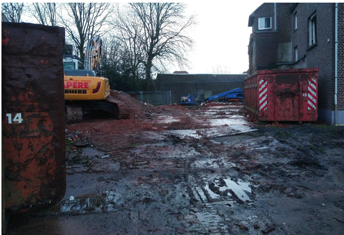
Figuur 9: Overzicht van het terrein ter hoogte van proefsleuf 3, voor het aanleggen.
