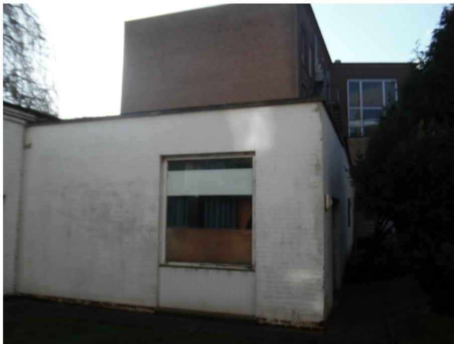
Figuur 6: zicht op het te slopen gebouw ( kantoorruimte en werkplaats)
