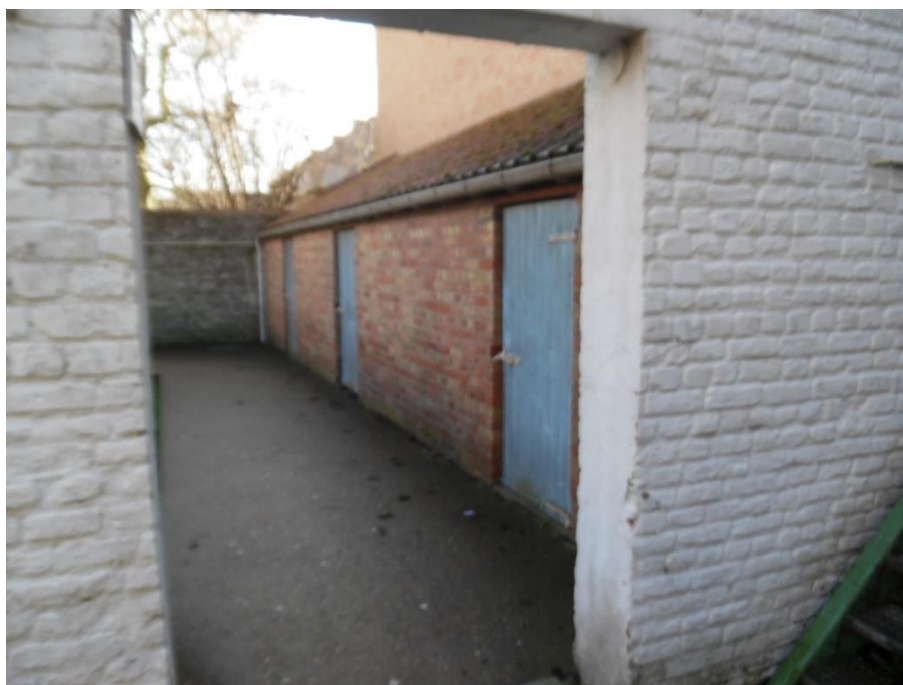
Figuur 7: zicht op de doorgang naar Vleeshouwersstraat 18. De bergingen in baksteen met blauwe deuren worden eveneens gesloopt. Merk ook de bestaande verharding in beton
