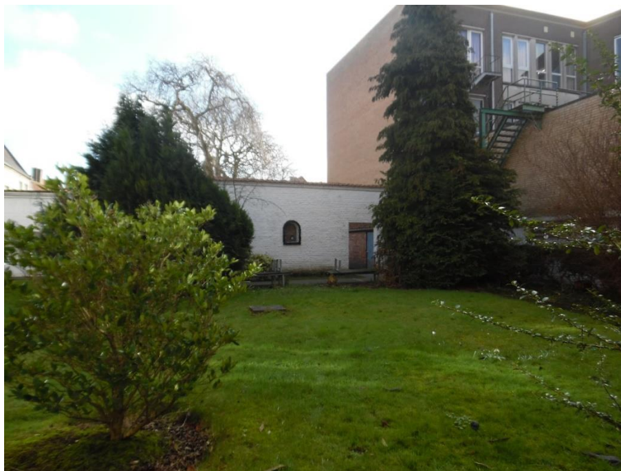
Figuur 4: zicht op de bestaande toestand. De witte gebouwen worden gesloopt in functie van de sanitaire nieuwbouw. De boom en het struikgewas rechts aan de vluchtrap worden gerooid
