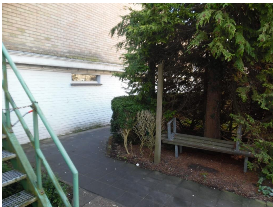
Figuur 5: de vluchtrap met de te rooien bomen en struiken. Vooraan bestaande verharding in betonklinkers en beton
