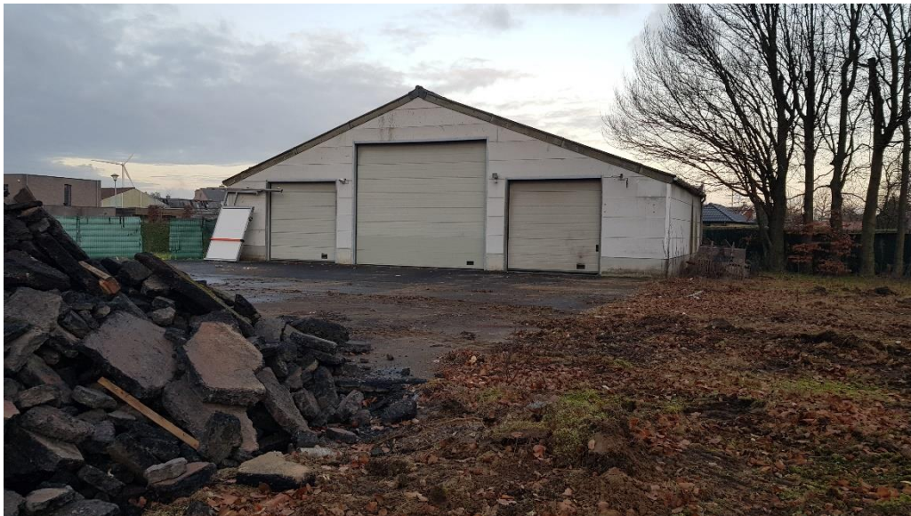
Figuur 12: Foto's situatie terrein ten tijde van het proefsleuvenonderzoek; zicht op de groenzone met te behouden bomen (boven) en zicht op de noordelijke te behouden loods (onder).
