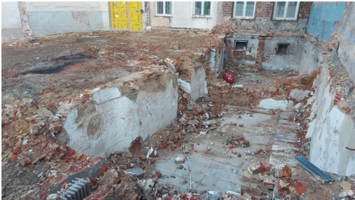
Figuur 51: Zicht op de kelder in het noordoosten van het onderzoeksterrein tegen de te bewaren gevel van het herenhuis uit de 2 e helft van de 19 de eeuw aan de Hoogstraat. Merk linksboven de oranje en zwarte brandsporen op die zich meteen onder de vloerplaat van de afgebroken huizen bevond.
