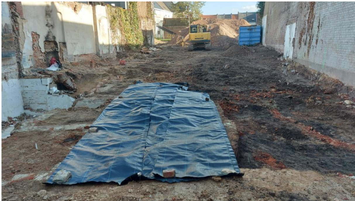
Figuur 16: De met geotextiel afgedekte zone ter hoogte van WP5.
