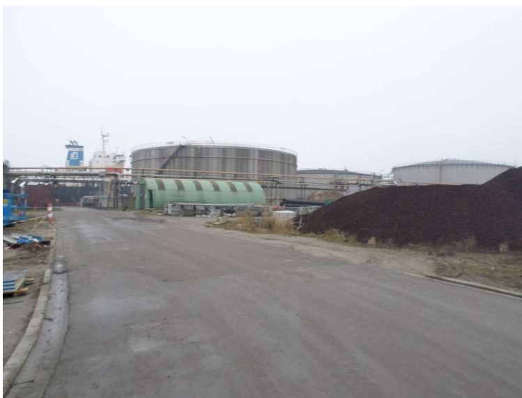
Figuur 5. Foto bestaande toestand richting noordoosten.
