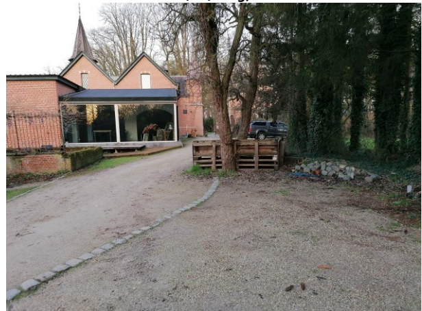
Foto 6: Achtergevel en begroeiing Koetshuis (ABO nv, 10/01/2023)
