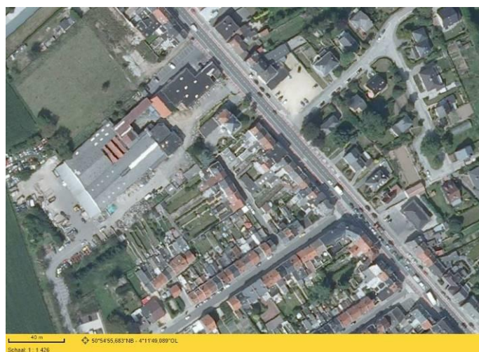
Fig. 46: Luchtfoto, grootschalig, zomer 2009 (© http://www.geopunt.be , bewerkt door Triharch, Onderzoek en Advies bvba).
