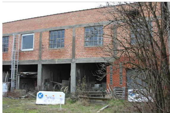
Fig. 57: Het L-vormig gebouw (© Kristine Magerman, Agilas vzw).
