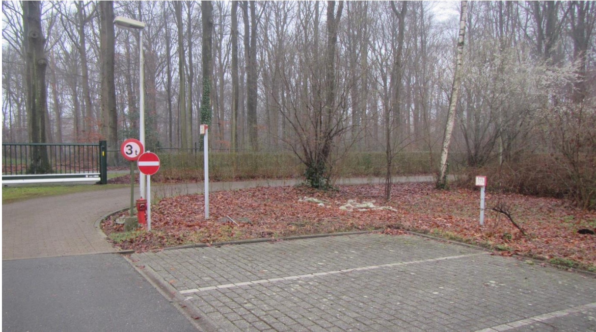
Figuur 39: Terreinopname met zicht op bovengronds aangeduide nutsleidingen
