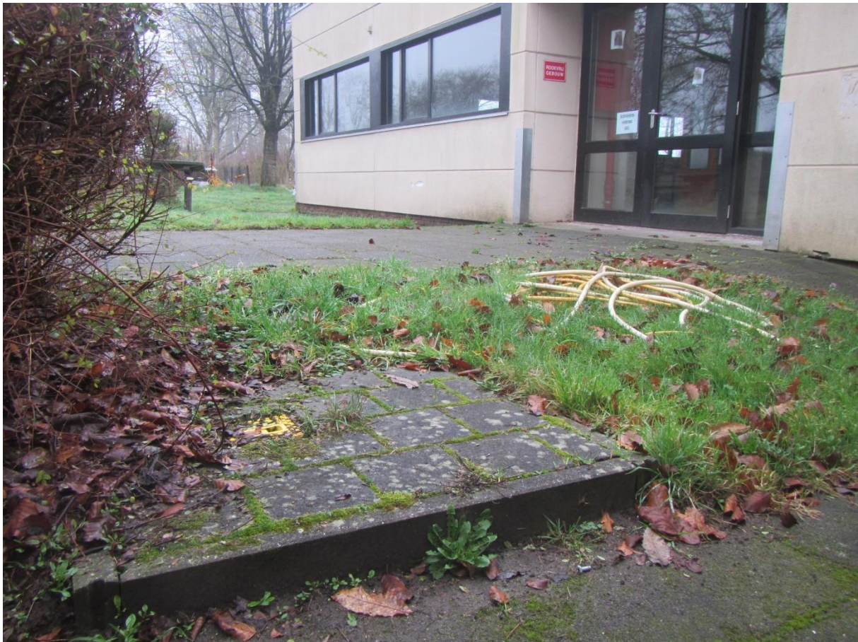
Figuur 37: Terreinopname met zicht op bovengronds aangeduide nutsleidingen
