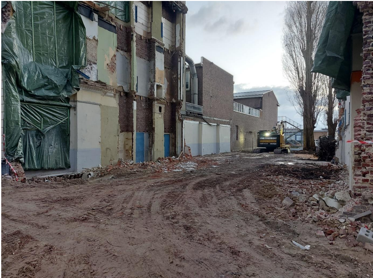
Figuur 48: Zicht op de perceel n°51 ter hoogte Sint-Pietersnieuwstraat (© Monument Vandekerckhove).
