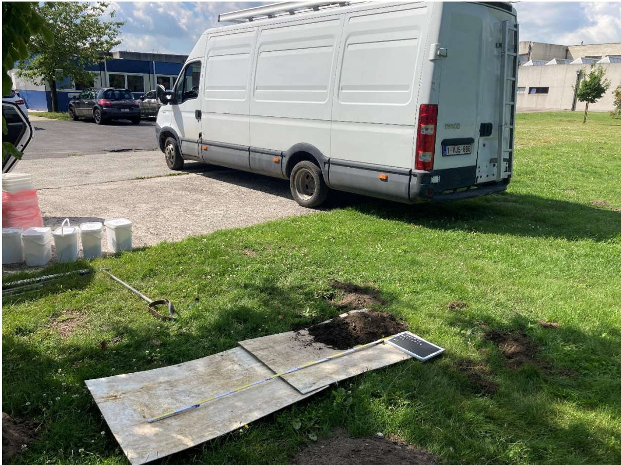
Figuur 6: Boring B7 werd na drie pogingen gestaakt op 47cm-mv vanwege puin en mogelijke verharding.
