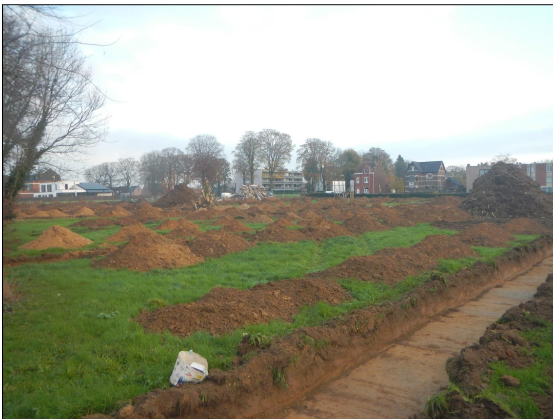
Figuur 24: Zicht op een deel van de proefsleuven.
