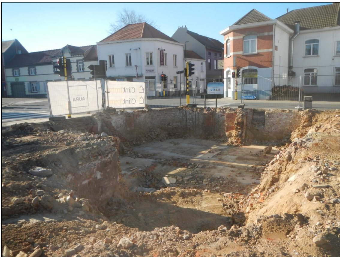
Figuur 23: Kelderruimte van het voormalig restaurant op de hoek van de Terhulpensesteenweg en de Hoeilaartsesteenweg.
