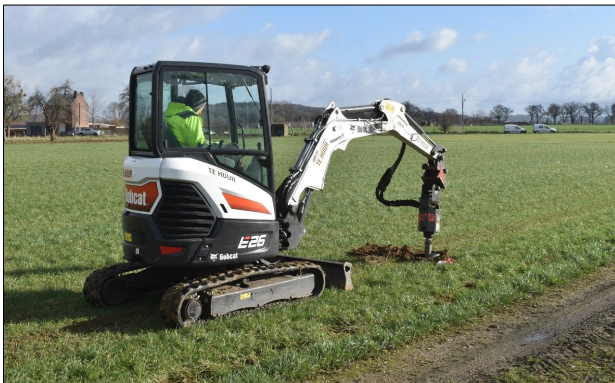
Afb. 25: Mechanische uitvoer van de verkennende archeologische boringen.
