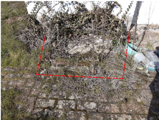
Foto 7: Septische put of waterput aan de achtergevel van de villa.
