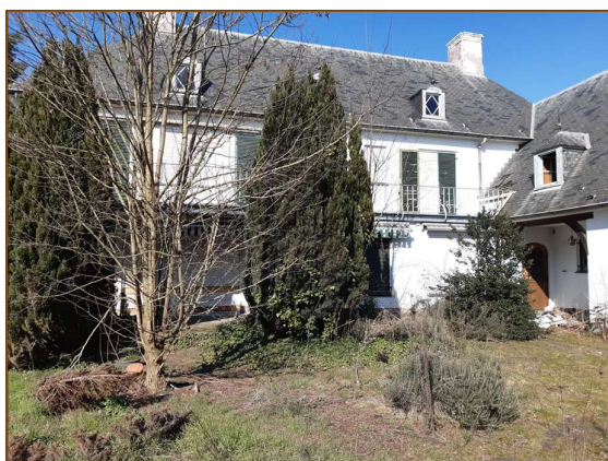
Foto 3: Achtergevel van de villa. Verharding (Z naar N)
