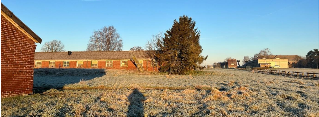
Figuur 6 : Zicht op de advieszone ter hoogte van boring 1, gezien vanuit het zuidoosten.
