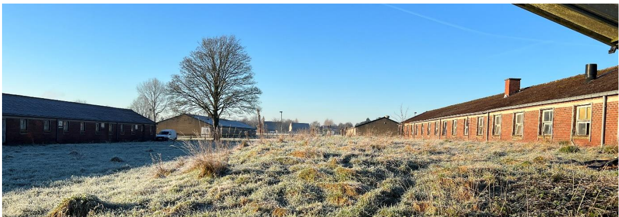
Figuur 7 : Zicht op het centrale deel van de advieszone ter hoogte van boring 2 t/m 4, gezien vanuit het noordoosten.
