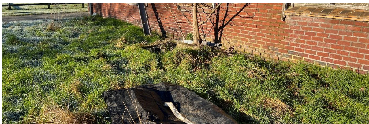
Figuur 14 : Zicht op de advieszone ter hoogte van boring 4A, gezien vanuit het oosten.
