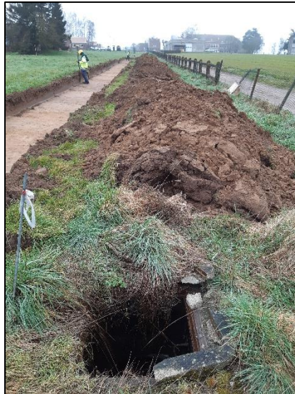
Figuur 23: Foto van een open put tijdens het onderzoek
