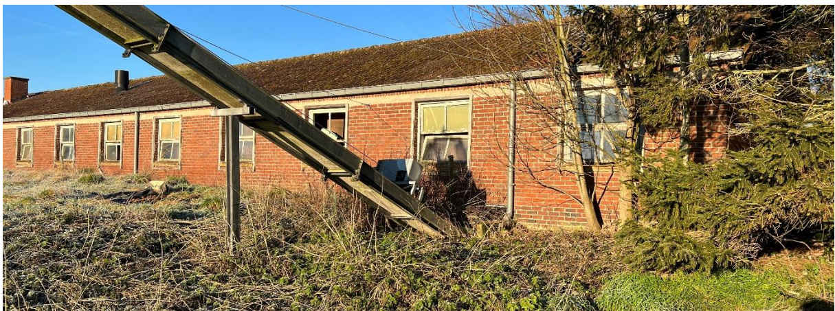
Figuur 8 : Zicht op de advieszone ter hoogte van boring 2, gezien vanuit het oosten.
