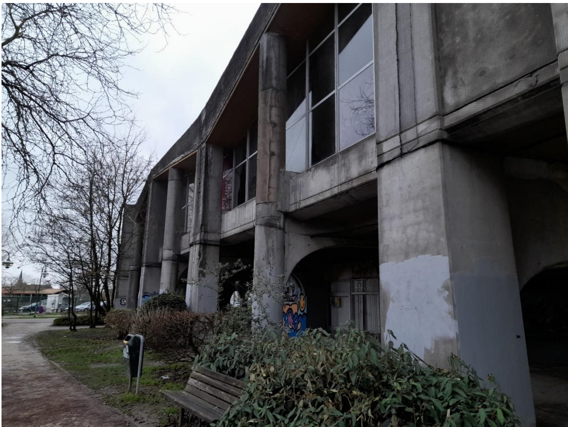
Figuur 5: Foto bestaande bebouwing
