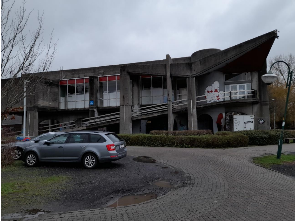
Figuur 4: Foto bestaande bebouwing
