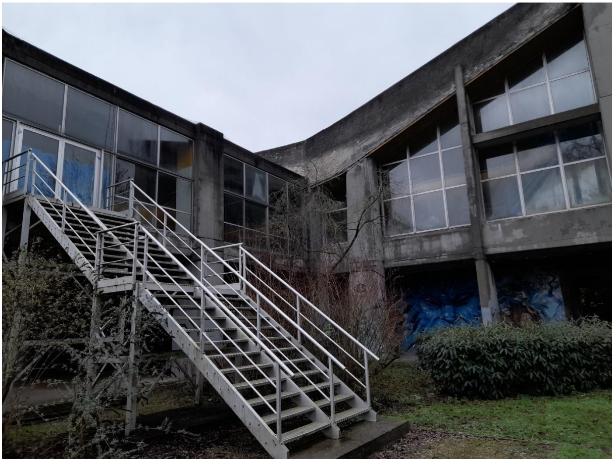
Figuur 3: Foto bestaande bebouwing
