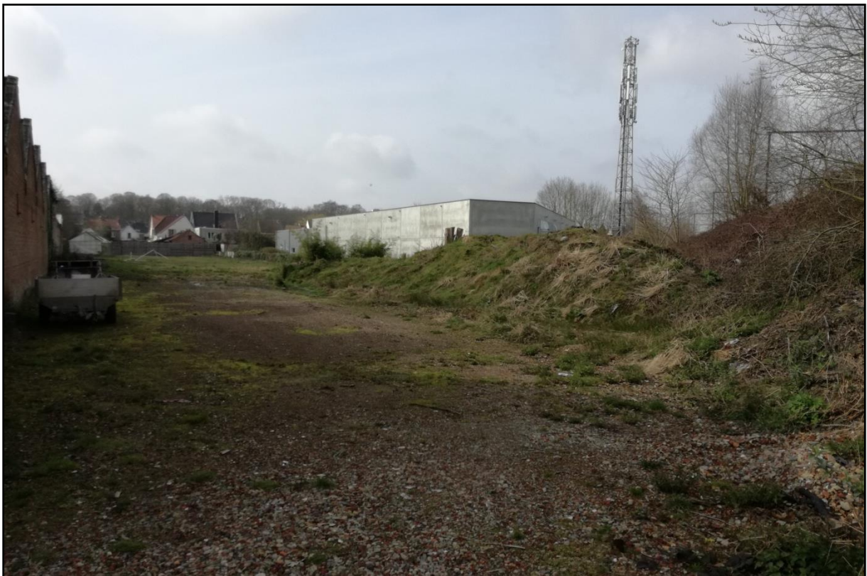
Figuur 3 Zicht op het noordelijke braakliggende terrein waar twee nieuwe loodsen opgetrokken worden. Rechts is de huidige spoorweg en spoorwegberm te zien.
