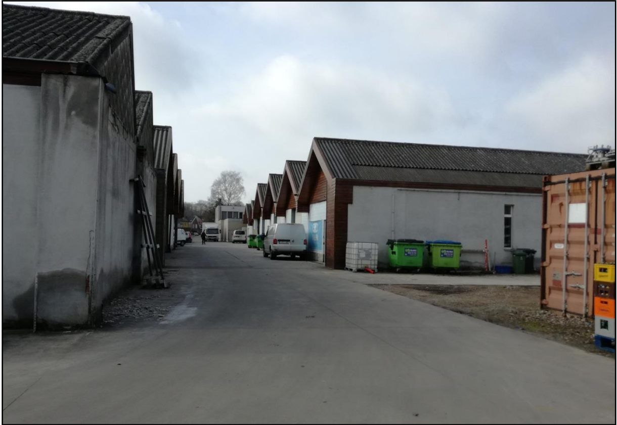
Figuur 2 Zicht op de huidige toestand met de aanwezige verhardingen en de loodsen 3 en 4 (centraal en noorden).
