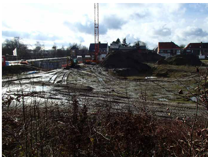
Figuur 19: Terreininspectie foto 5
