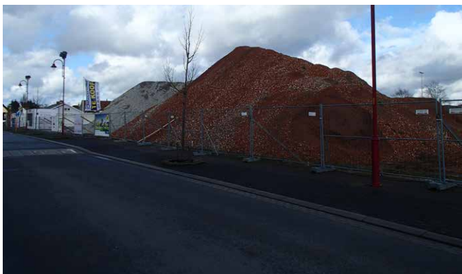
Figuur 15: Terreininspectie foto 1
