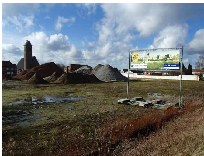
Figuur 20: Terreininspectie foto 6
