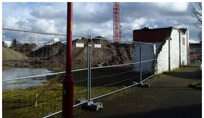
Figuur 16: Terreininspectie foto 2
