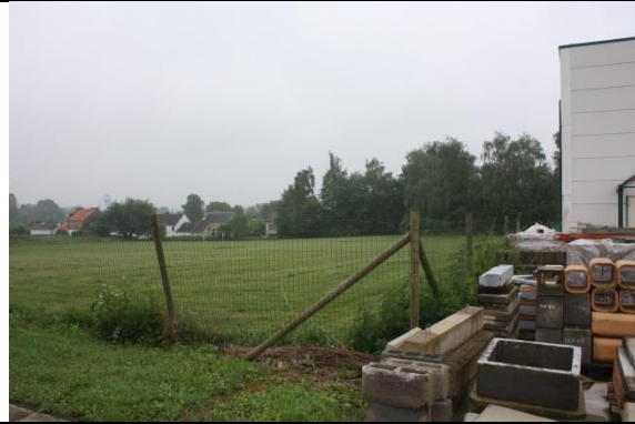
7 werkplaats mechanica G05 (af te breken)
