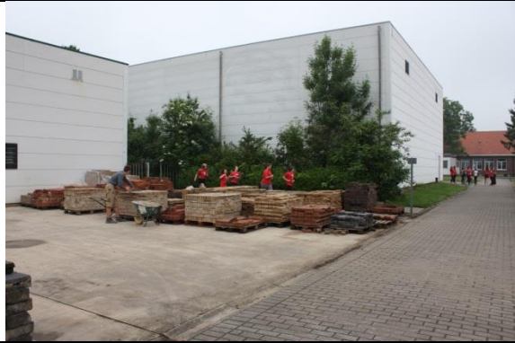
7 werkplaats mechanica G05 (af te breken)
