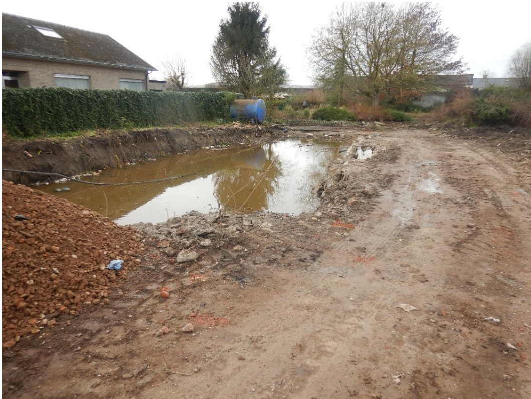
Figuur 19: Werkfoto verharding en uitgebroken kelder onder huis 2B
