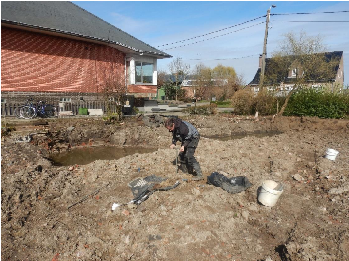
Figuur 20: Werkfoto uitgebroken kelder en regenwaterput onder huis 2A
