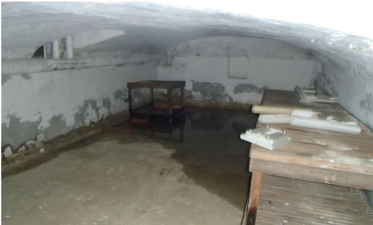
Figuur 3: Zicht op een van de kamers in de kelder
