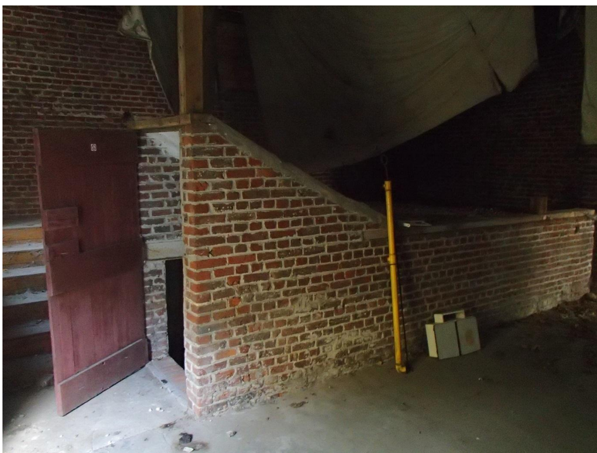
Figuur 5: Zicht op de half-ondergrondse kelder in de stal/schuur
