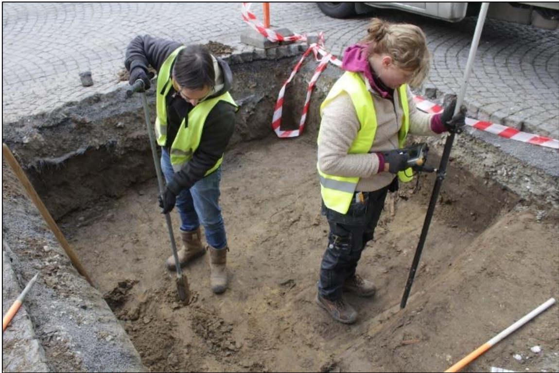
Figuur 12: Foto genomen tijdens het inmeten van vlak 2 en de boring in werkput 2 (ABO nv 2023)
