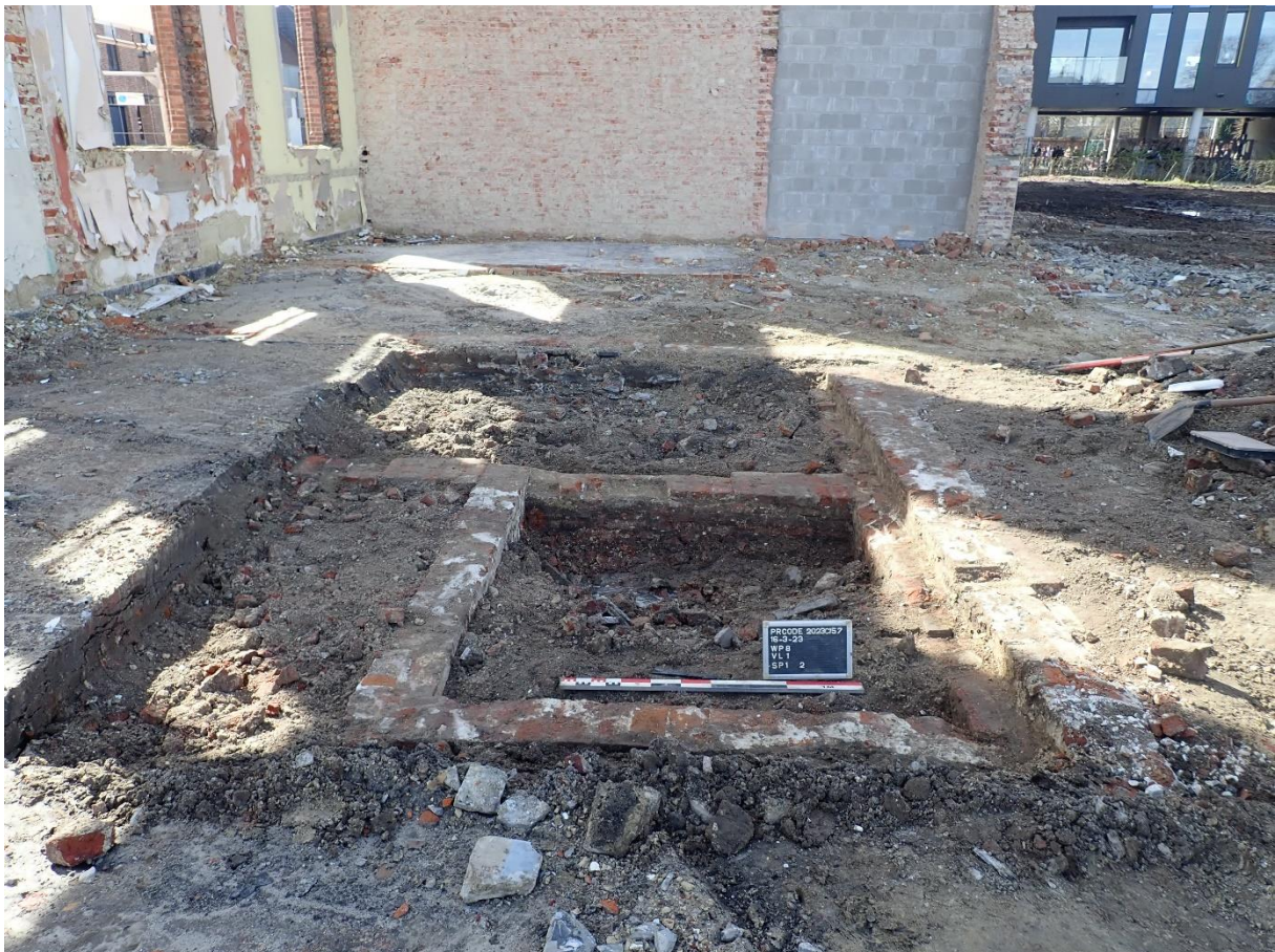
Figuur 40: Werkput 8, Vlak 1: Muurwerk (Sp000801, Sp000802 en Sp000803)
