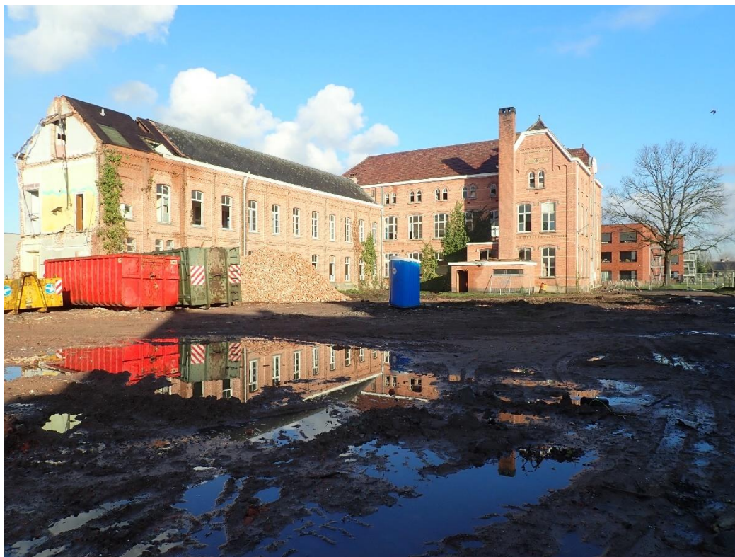
Figuur 3: Zicht op het terrein vanuit het noordoosten met grote plassen, berg stenen, containers en niet gesloopte bebouwing ter hoogte van Werkput 2 en Werkput 3
