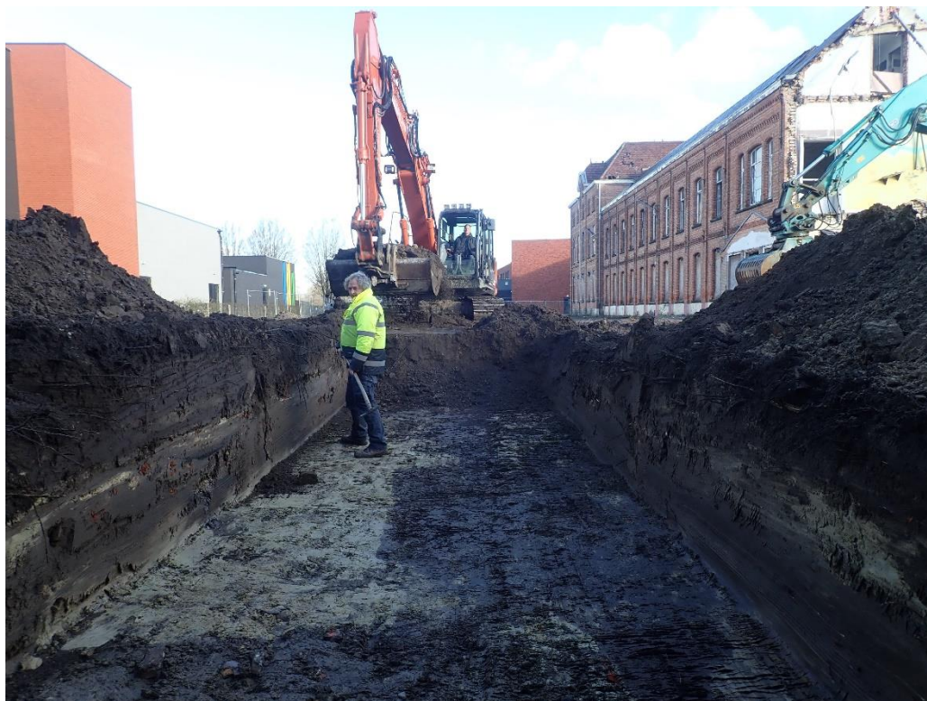
Figuur 4: Machinaal aanleggen van de sleuven (Werkput 1)
