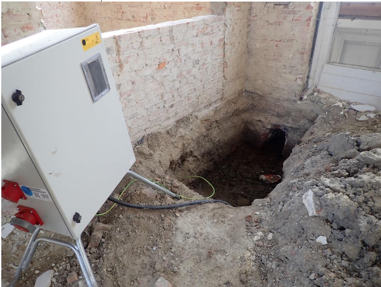
Figuur 6: Reeds gegraven put voor aansluiting werfkast elektriciteit ter hoogte van de voorziene Werkput 5
