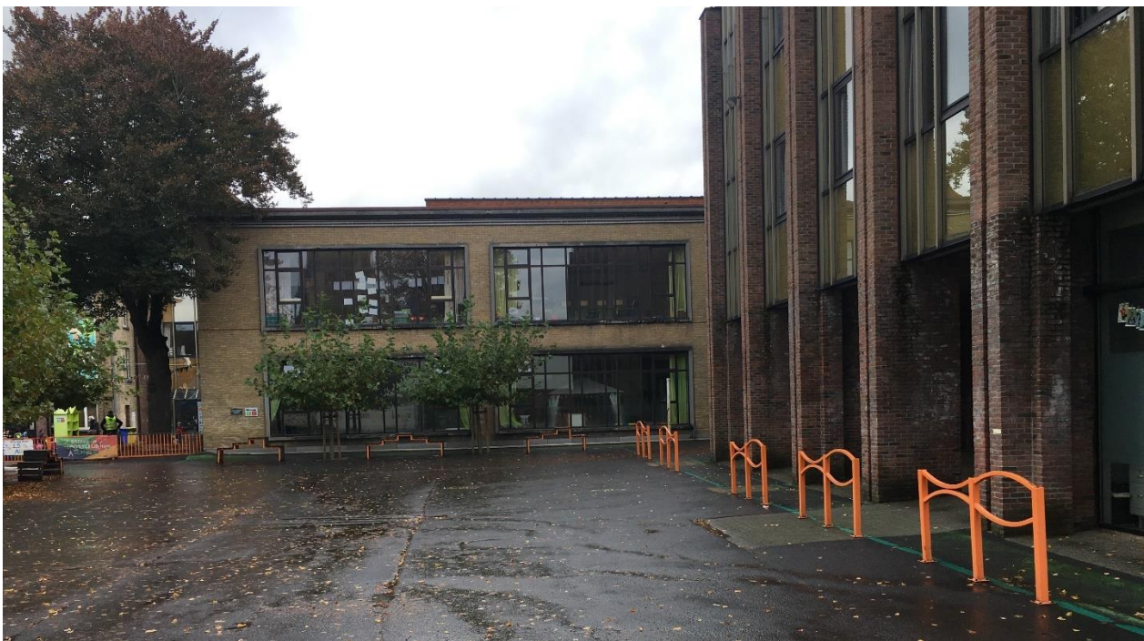
F3-F4: zicht op de te slopen schoolgebouwen uit de jaren 1980
