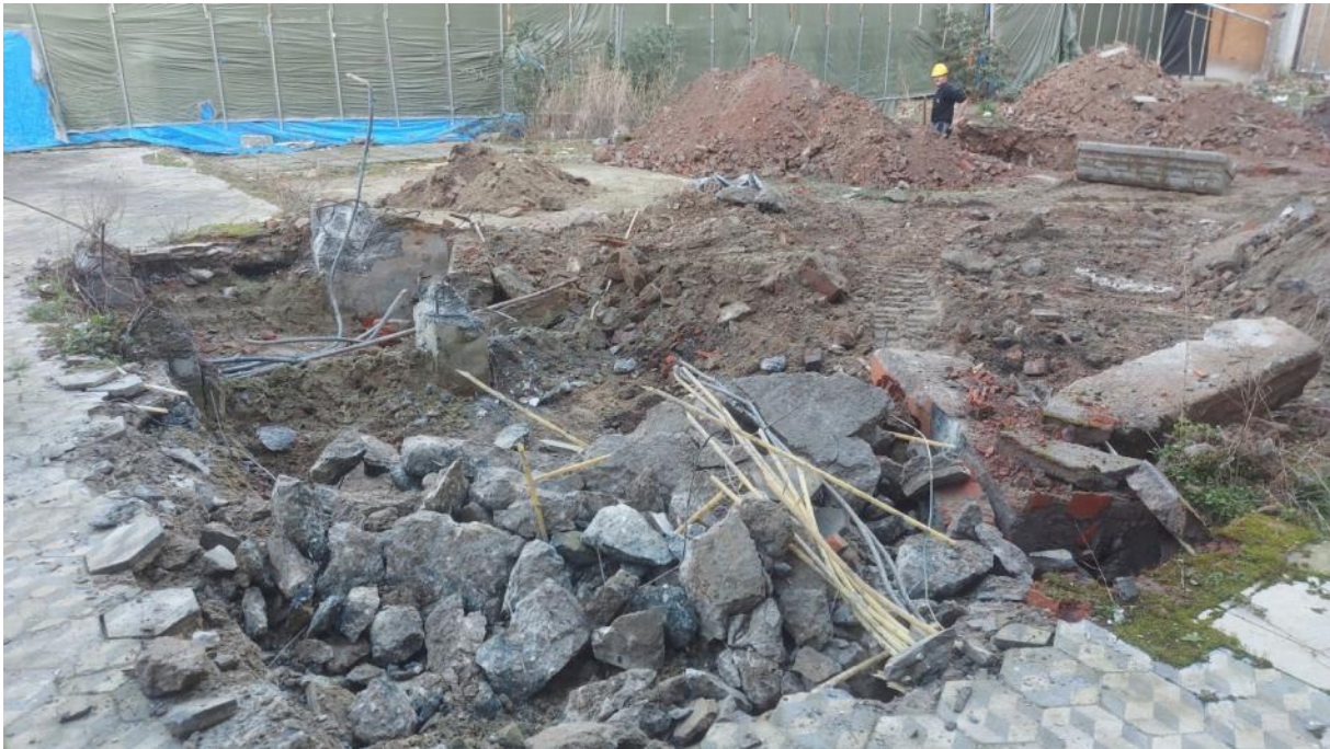
Figuur 9: Zicht op de hoge mate aan recente versterking in het zuidwestelijke deel van het terrein in de vorm van een dikke betonnen vloerplaat en op regelmatige afstand van elkaar geplaatste paalfunderingen in gewapend beton.
