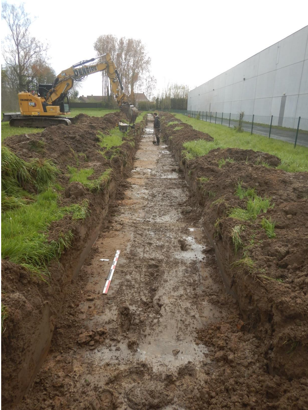
Figuur 38: fotografische opname van een leidingsegment in werkput 1.
