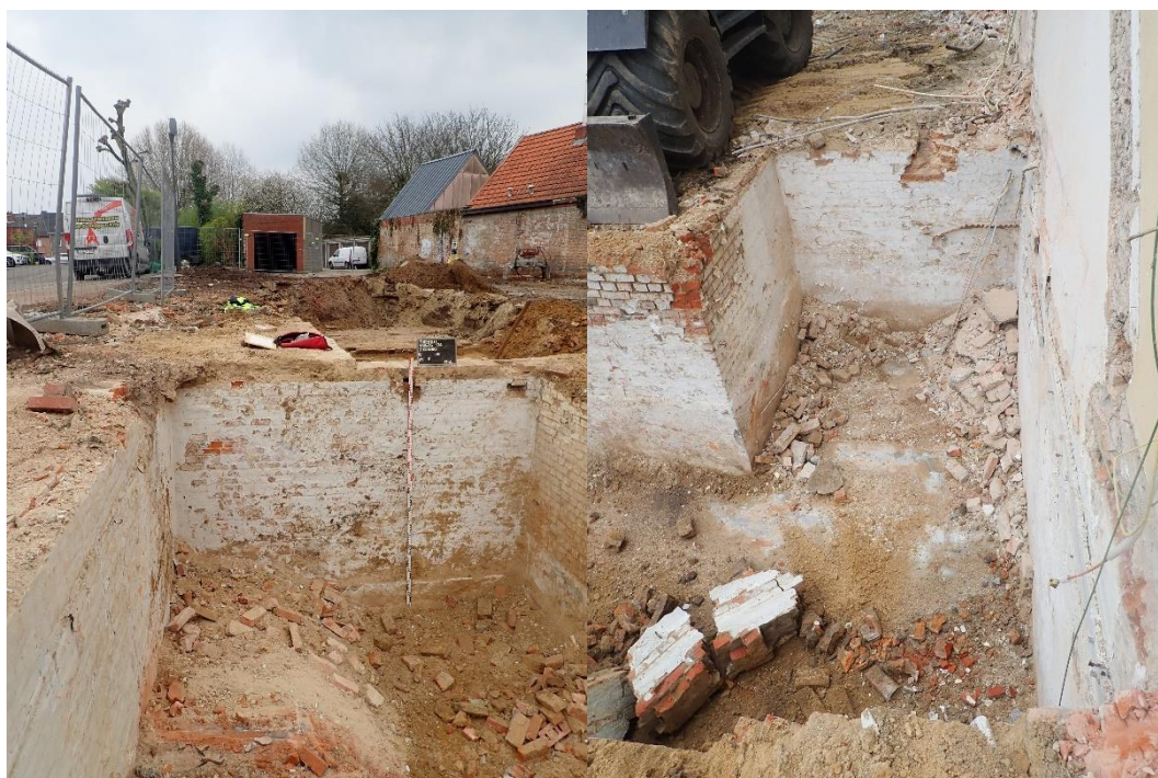
Figuur 8: Zicht op aanwezige kelders • J. Verrijckt Bvba
