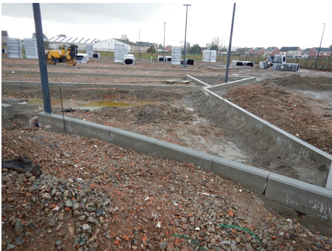
Figuur 5. Zicht op de werkzaamheden voor de aanleg van de parking ten westen ©ADEDE bvba.
