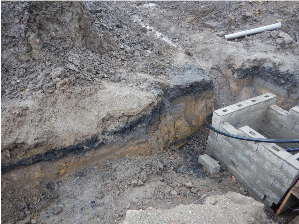
Figuur 2. Zicht op een overloopput ©ADEDE bvba.
