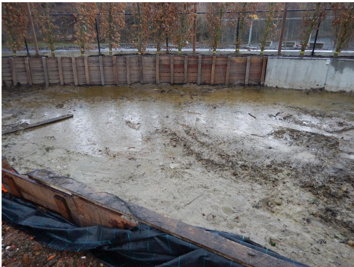
Figuur 4. Zicht op het infiltratiebekken ©ADEDE bvba.
