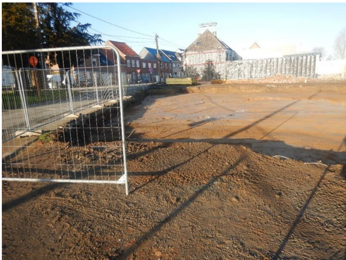
Figuur 14: Werkfoto afgegraven zone ter hoogte van gesloopt gebouw
