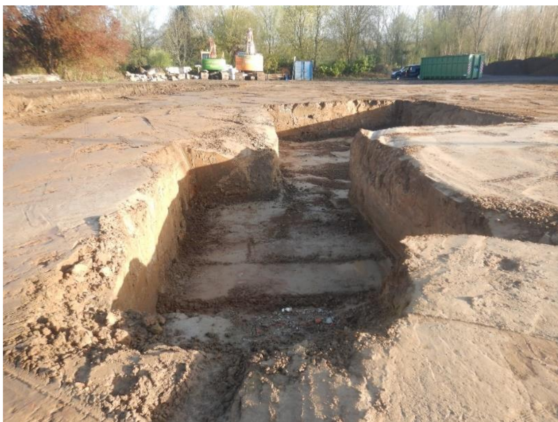
Figuur 15: Werkfoto uitgebroken kelder
