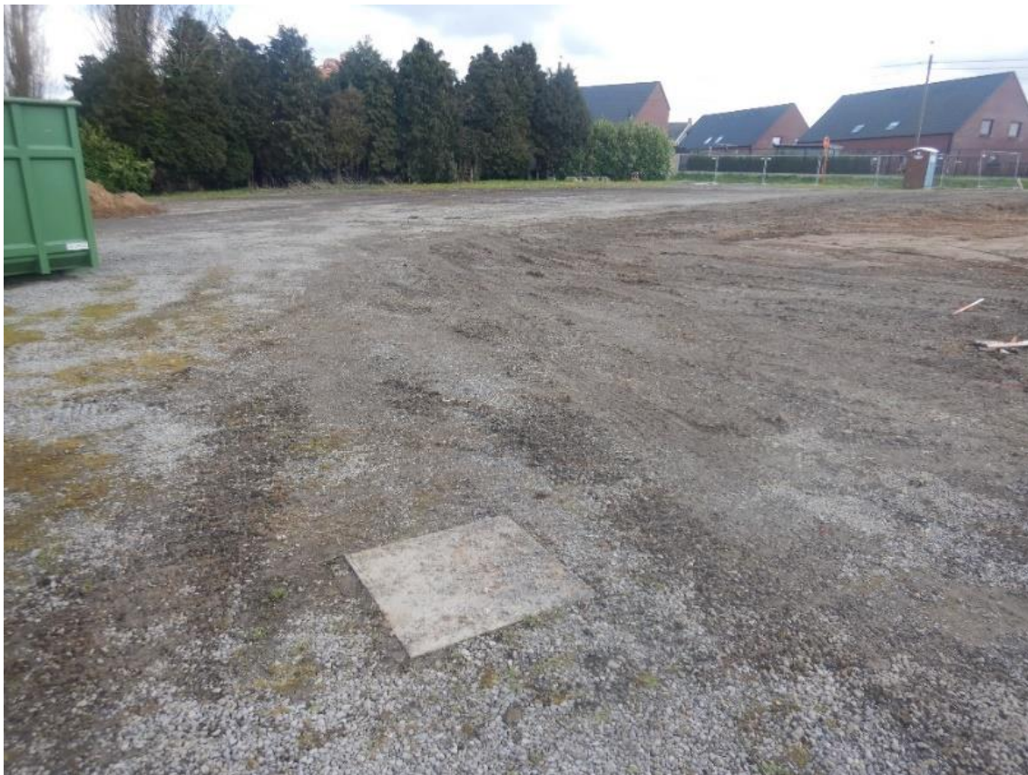
Figuur 11: Werkfoto verharde grindparking en putdeksel
