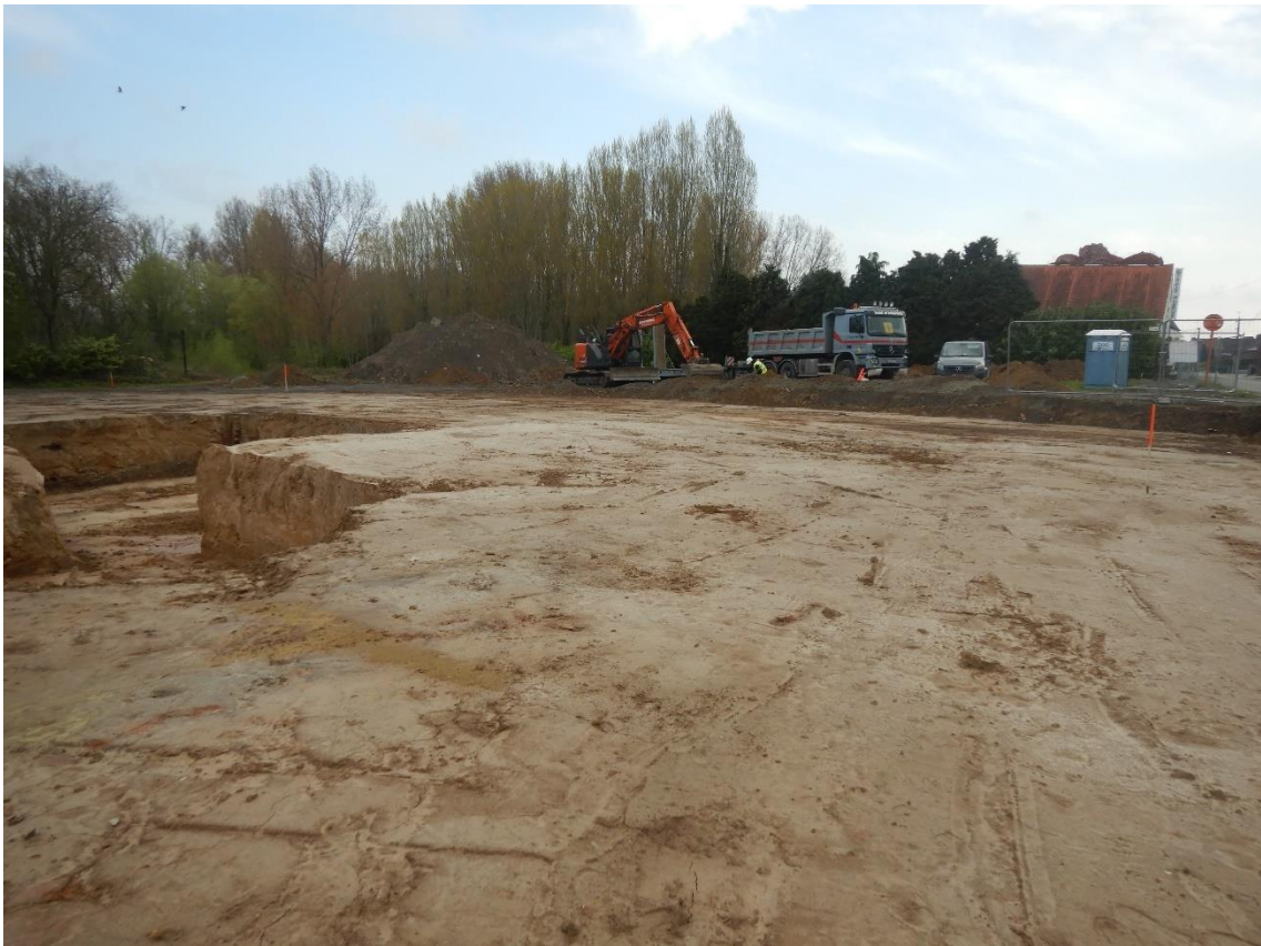
Figuur 31: Afgegraven zone ter hoogte van gesloopt gebouw met links de locatie van een diepere kelder
