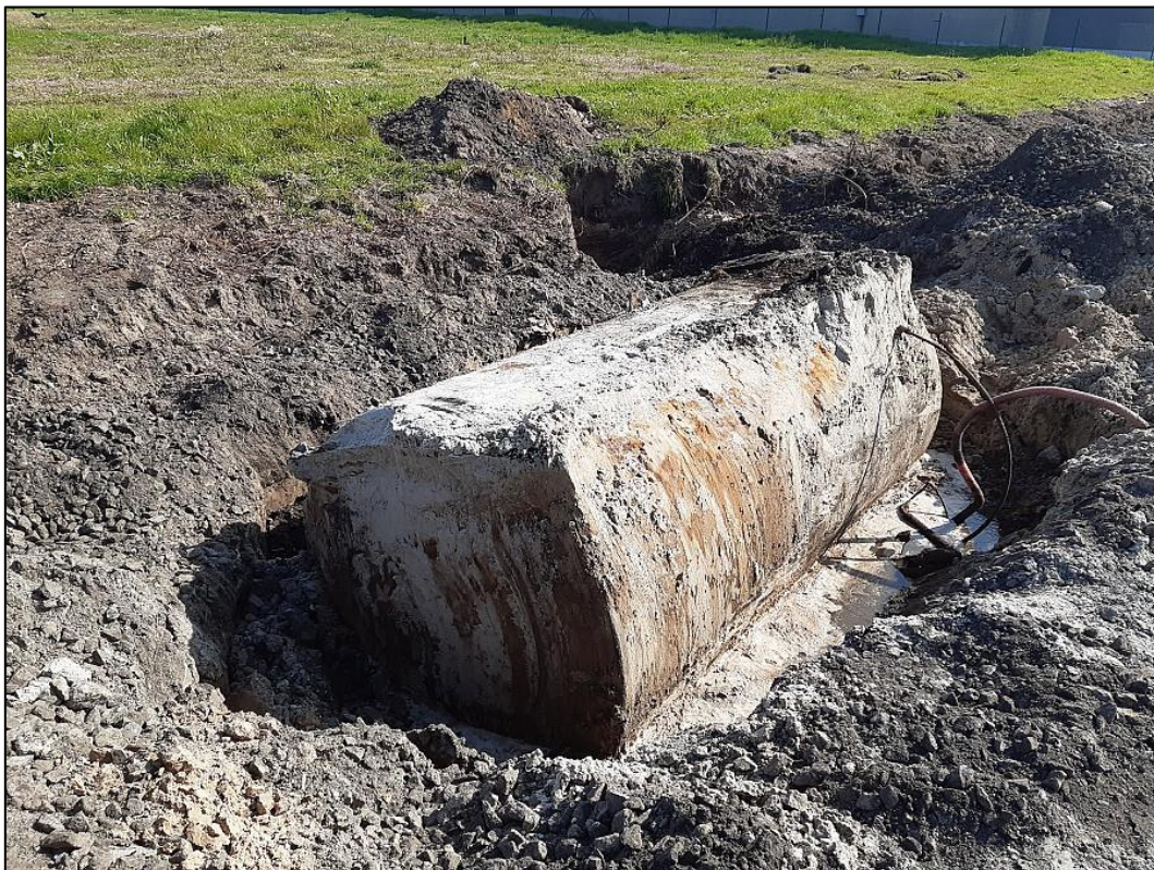
Figuur 6: Stookoliettank ter hoogte van perceel 485Y
