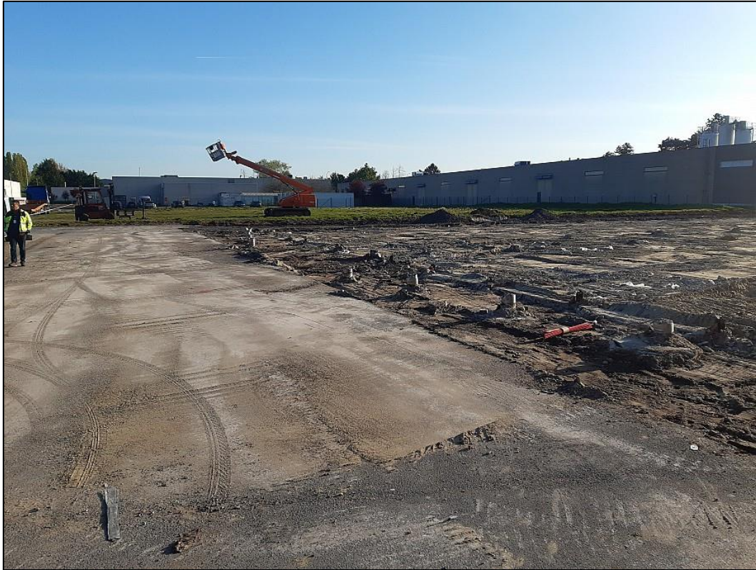
Figuur 5: Niet uitgebroken verharding van de voormalige parking
