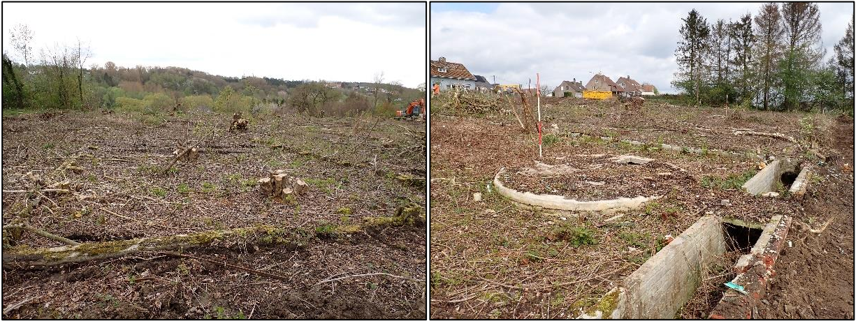
Afb. 13. De funderingen, bassins en verwarmingskanalen van de serres.
