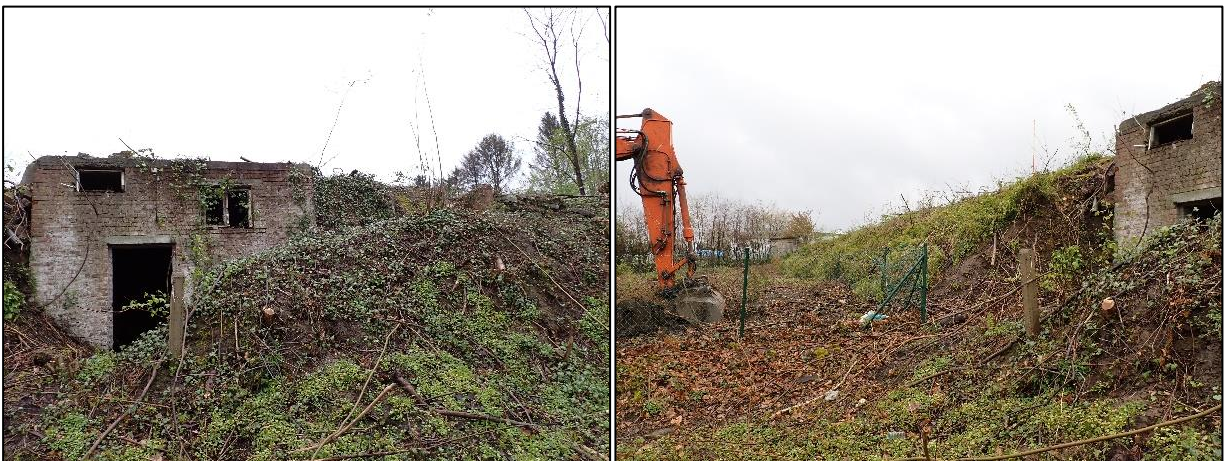
Afb. 14. Het verwarmingskot in de talud en het hoogteverschil tussen het noordelijk en zuidelijk terrein.
