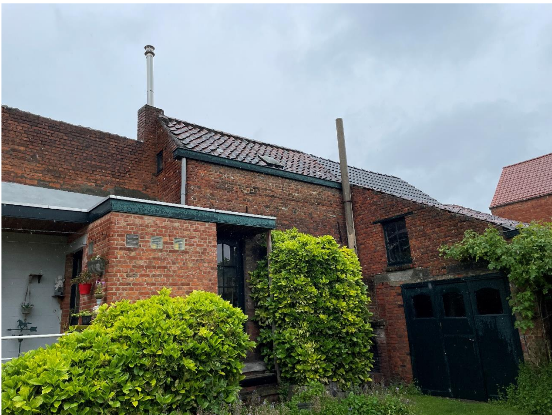
Figuur 4: Zicht op de bestaande toestand (huisnr. 41)
