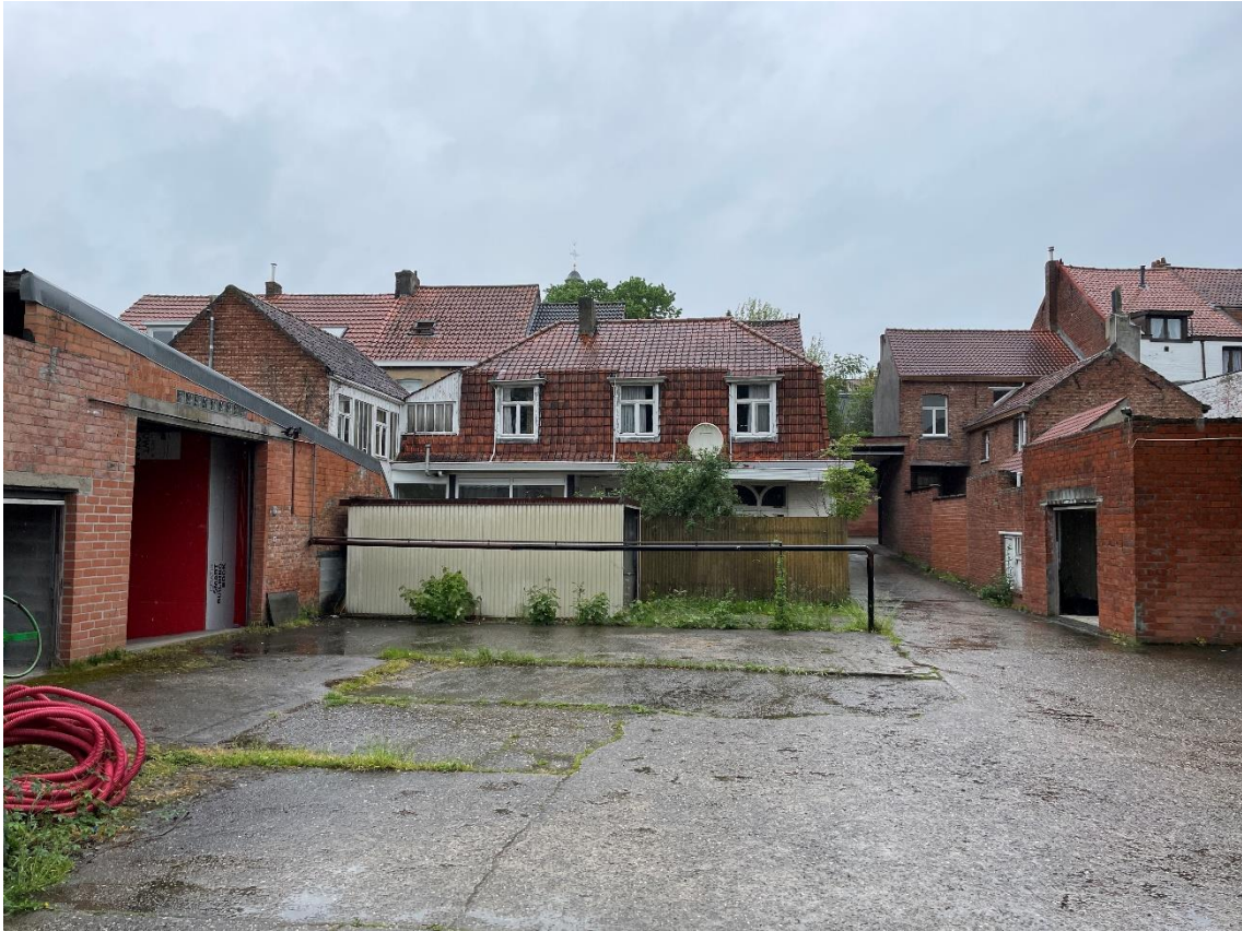
Figuur 3: Zicht op de bestaande toestand (huisnr. 25)
