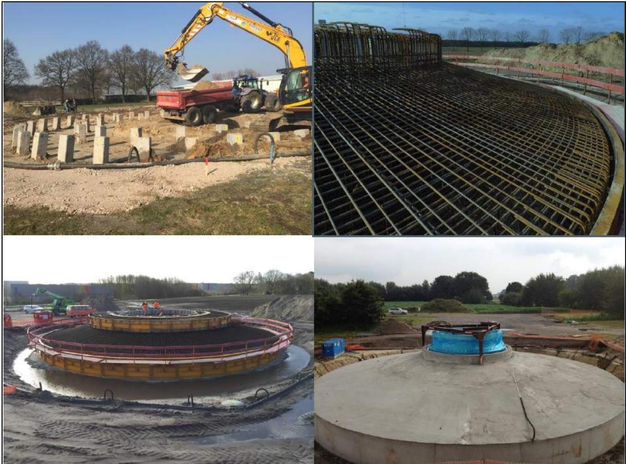
Afb. 3: Funderingen (project initiatiefnemer, Meer en Wachtebeke) (Bron: initiatiefnemer, dd 03/01/2016, 2016L203)
