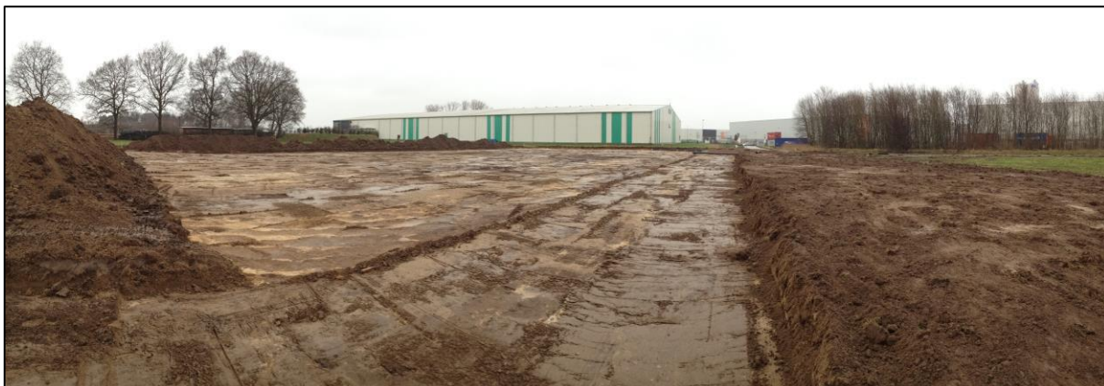
Afb. 4: Permanente werkzone in aanleg (project Storm, Meer) (Bron: initiatiefnemer, dd 03/01/2016, 2016L203)
