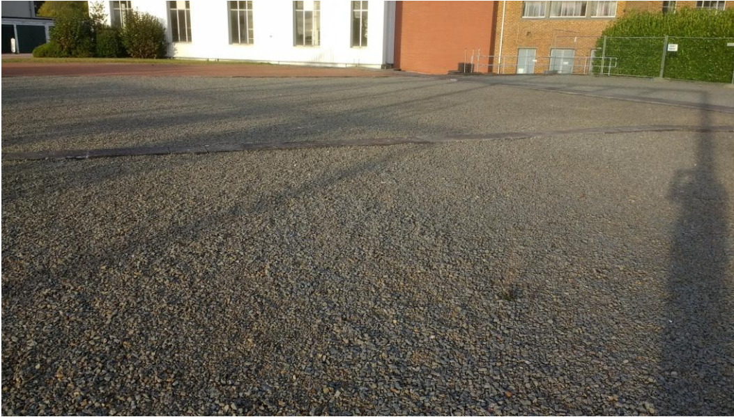
Afb. 10. Gebouwen met vooraan de kabelgoten die afgedekt zijn met betonnen tegels.
