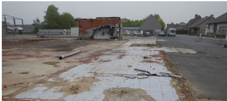
Figuur 7. Zicht op de verlaten loods in aanbouw en de elektriciteitscabine.
