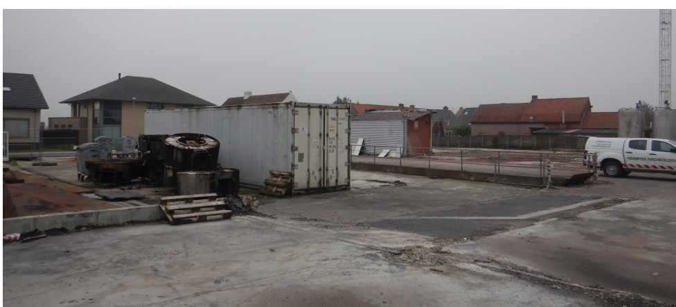
Figuur 6. Beelden van de brand in juni 2022. Onder: het tegenovergestelde zicht tijdens het plaatsbezoek. Let op de verbrande machines links onder op de foto.
