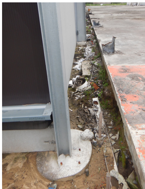
Figuur 9. Zicht op de funderingszolen van de loods in aanbouw. Let op de diepte van de top van de zolen ten opzichte van de vloerpas van de verharding.
