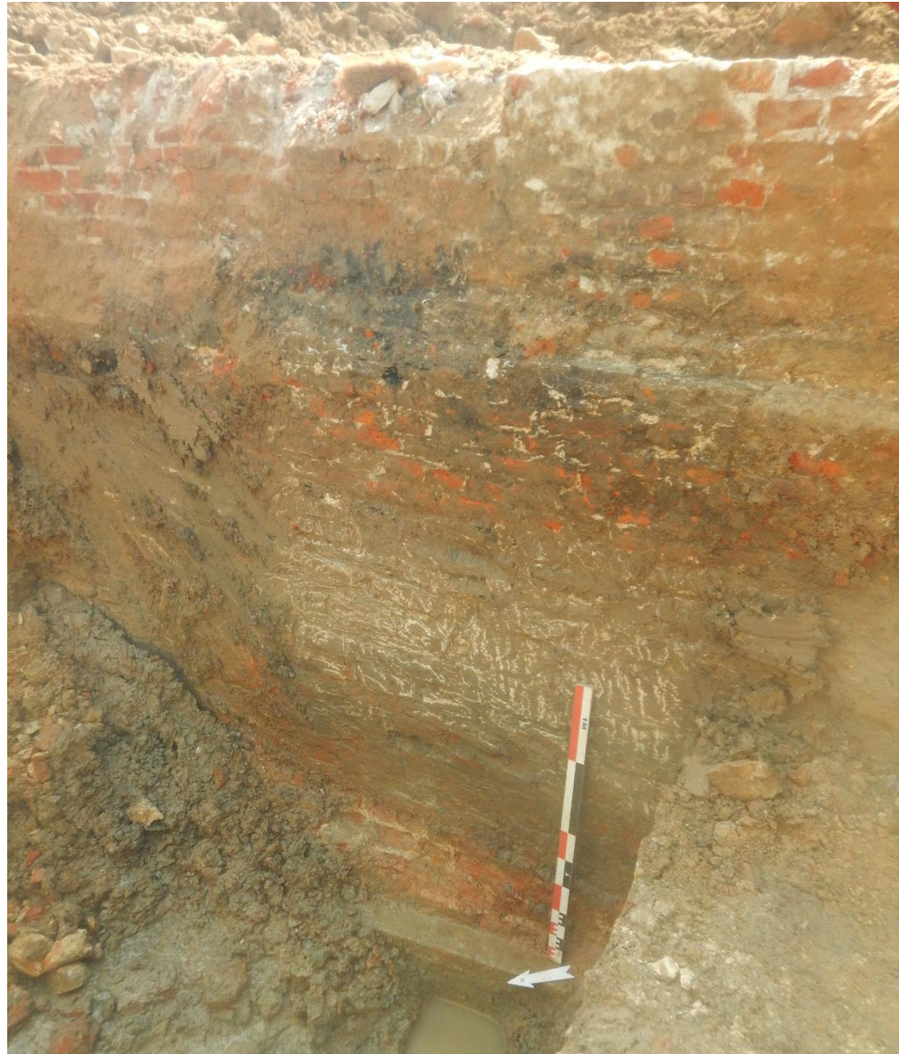
Figuur 54: Fotoreportage profiel P7 tegen de buitenzijde [noordkant] van S3;Aangelegd op zoek naar de ondergrens van de fundering; van top tot ondergrens meet het profiel 2.7 m [15.2 m TAW tot 12.48 m TAW]; stabiliteit, waterinfiltratie en veiligheid maakten dieper graven onmogelijk; We onderscheiden de opeenstapeling van minstens 6 verschillende bouwtechnieken, - zo niet fasen; We stellen met klem dat P7 eerder aan het oostelijke uiteinde van S3 is aangelegd, waar muurwerk algemeen van een slechtere kwaliteit was dan aan de westkant
