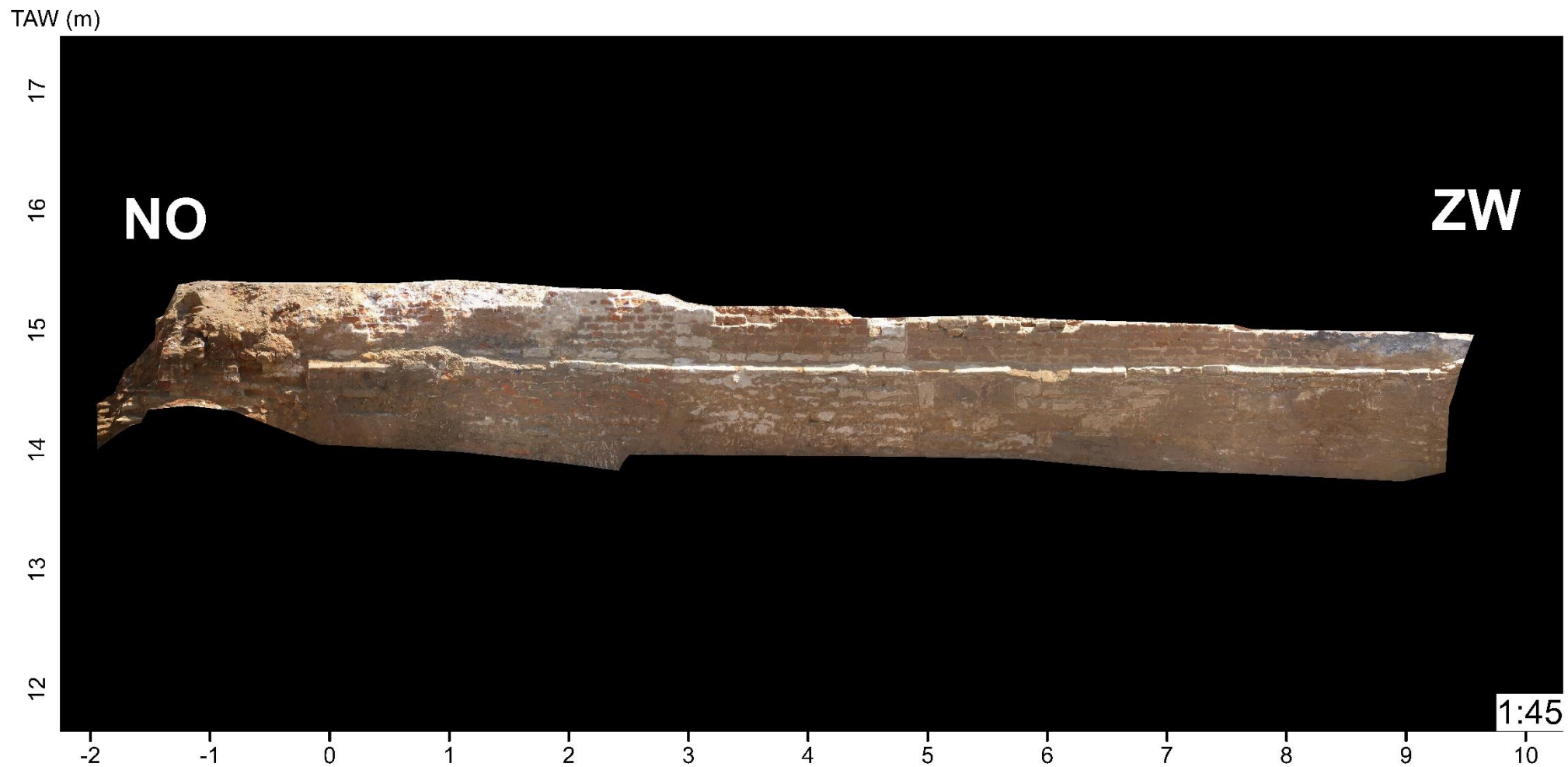
Figuur 55: Hoge resolutie fotogrammetrisch samengestelde orthofoto met uitdrukking van exacte hoogteligging [m TAW] en lengte [m] van S3 en S5; Hierin is merklijk verschil in bouwtechniek tussen de oost- (links) en westkant (rechts); bovenal is centraal een oudere uitbouw afgewerkt met kalkstenen hoeken volledig opgenomen in de muur
