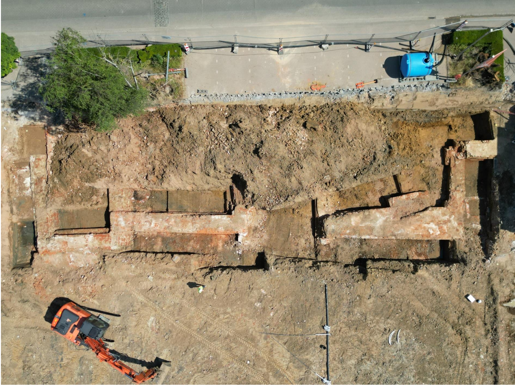
Figuur 41: Werkputoverzicht kasteelzone d.d. 12 juni 2023
