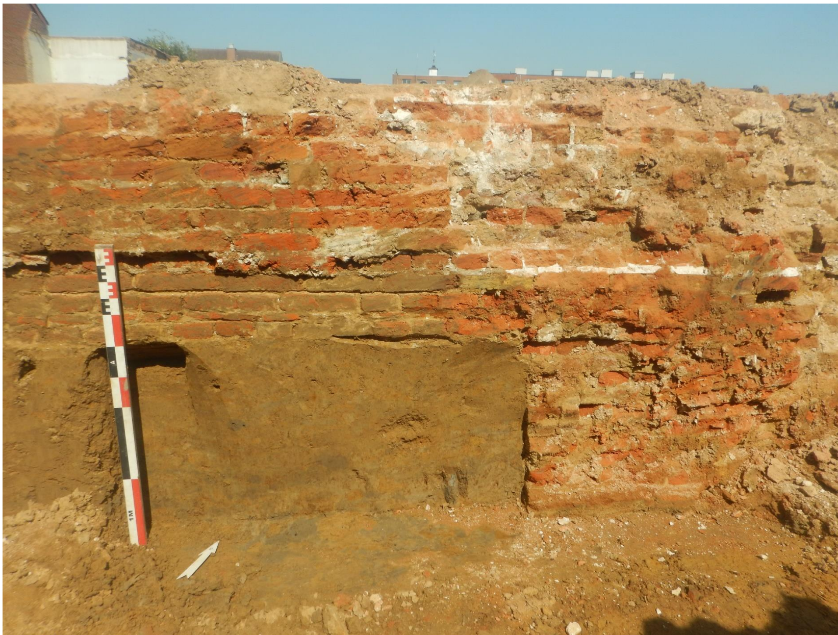
Figuur 48: Detailfoto S4 aan het oostelijke uiteinde en tégen S5 aan; waarop in profiel een niet bewaarde binnenmuur te zien is uitgevoerd in onregelmatig metselwerk met gerecycleerde baksteen [25 x 6 x12 cm]
