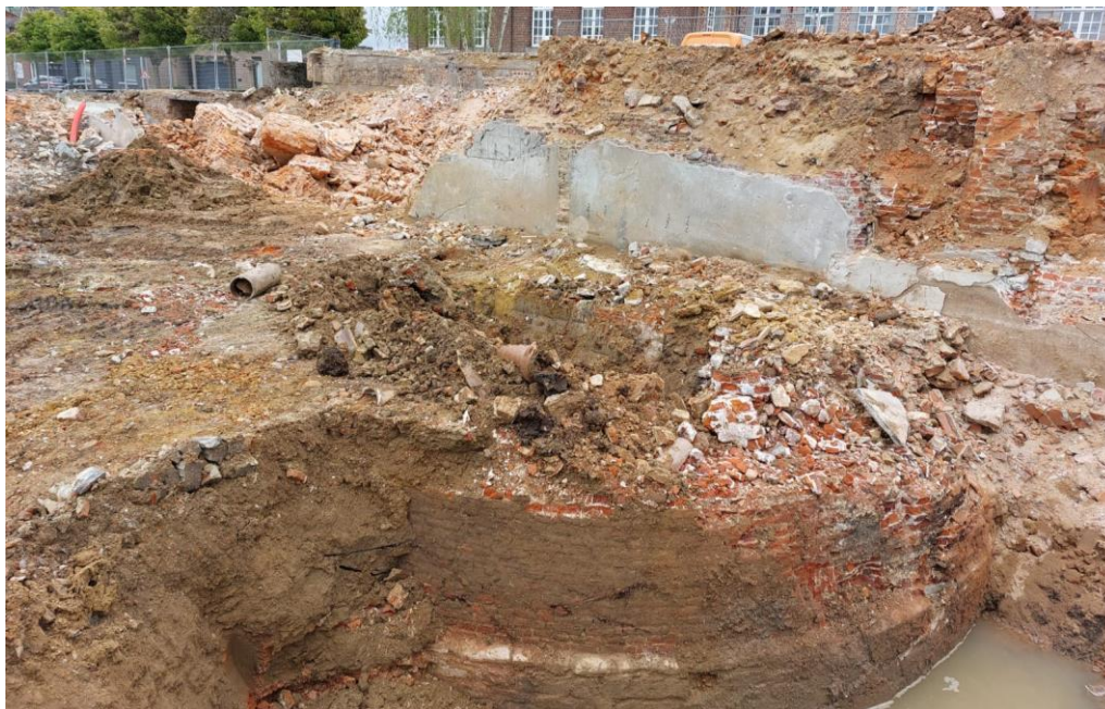
Figuur 58: Werkfoto sloopwerken aan de schoolkelder langs de Kasteelstraat d.d. april 2023; waarbij de ronde onderbouw van een toren is uitgebroken [© initiatiefnemer]
