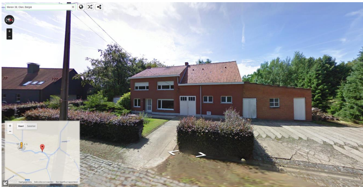
Figuur 4: Voorgevel van het bestaande pand (Google Street view, 2017)
